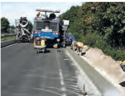
B45 Dreieck Dieburg-Rödermark / Ober-Roden (HE) Bankettbetoneinbau, Nachbehandlung
