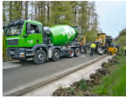
K1209 Büchenbronn (BW) Bankettbetoneinbau mit Offset-Gleitschalungsfertiger
