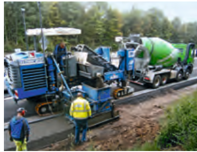
BAB A61 Gundersheim (RP) Bankettbetoneinbau mit dem Offset- Gleitschalungsfertiger
