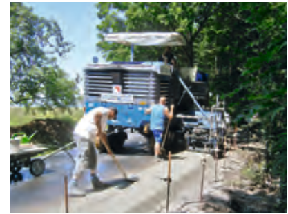
K1054 Hasenhof (BW) Bankettbetonstreifen hinter der Fertiger- einbaumulde
