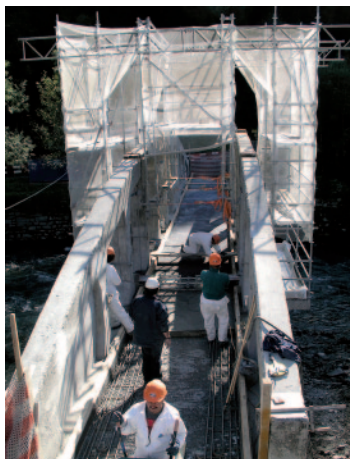
Einbau der multifunktionalen UHFB-Schicht (Verstärkung, Abdichtung, Fahrbahnbelag)
