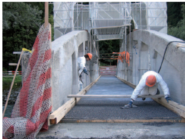
Einbau der multifunktionalen UHFB-Schicht (Verstärkung, Abdichtung, Fahrbahnbelag)
