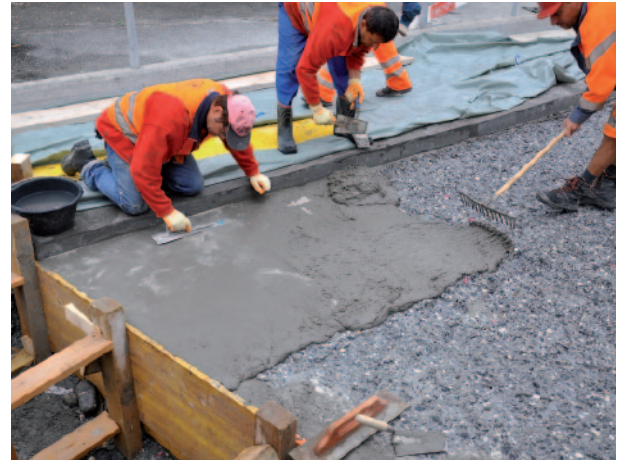
Bearbeitung der UHFB-Oberfläche
