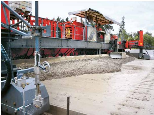
Abb. 6: Betoneinbau (Oberbeton) mit Gleitschalungsfertiger
