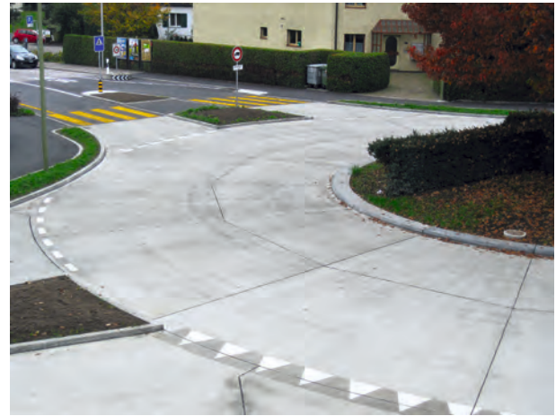
Ringfahrbahn unbewehrt, mit Mittellängsfuge, Kreisel Winterthurerstrasse in Bülach
