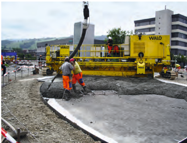
Maschineller Einbau Ringfahrbahn, Pumpbeton, Feldstrasse, Nordzufahrt Zug
