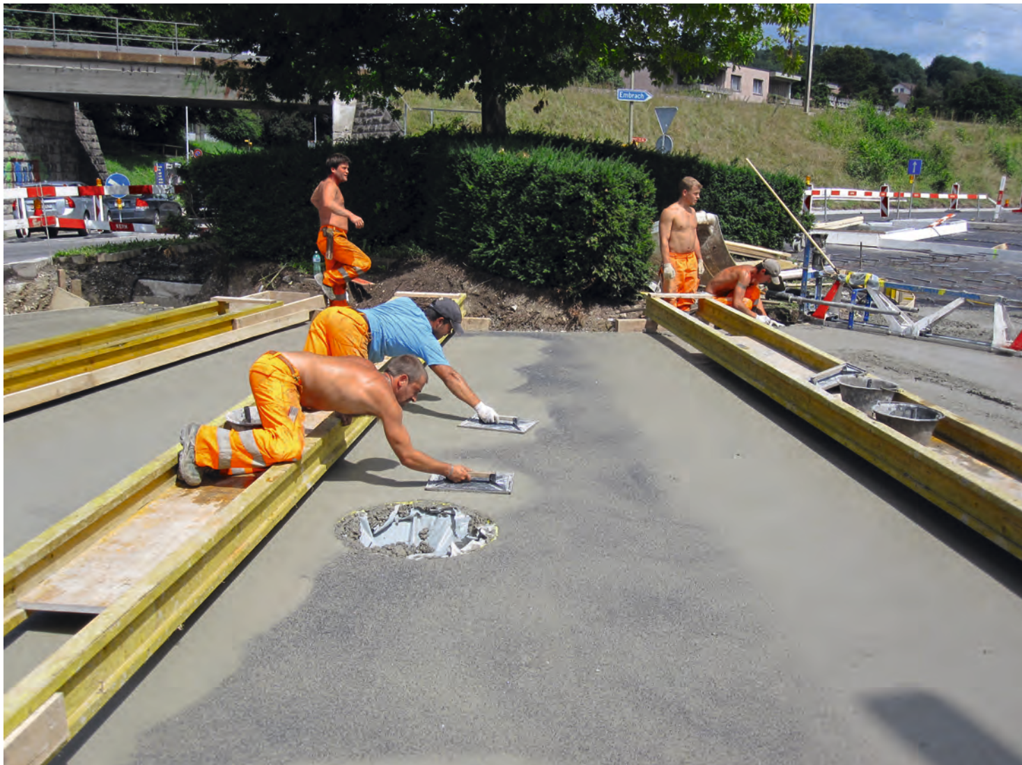
Einarbeiten des Hartstoffes, Kreisell Winterthurerstrasse in Bülach
