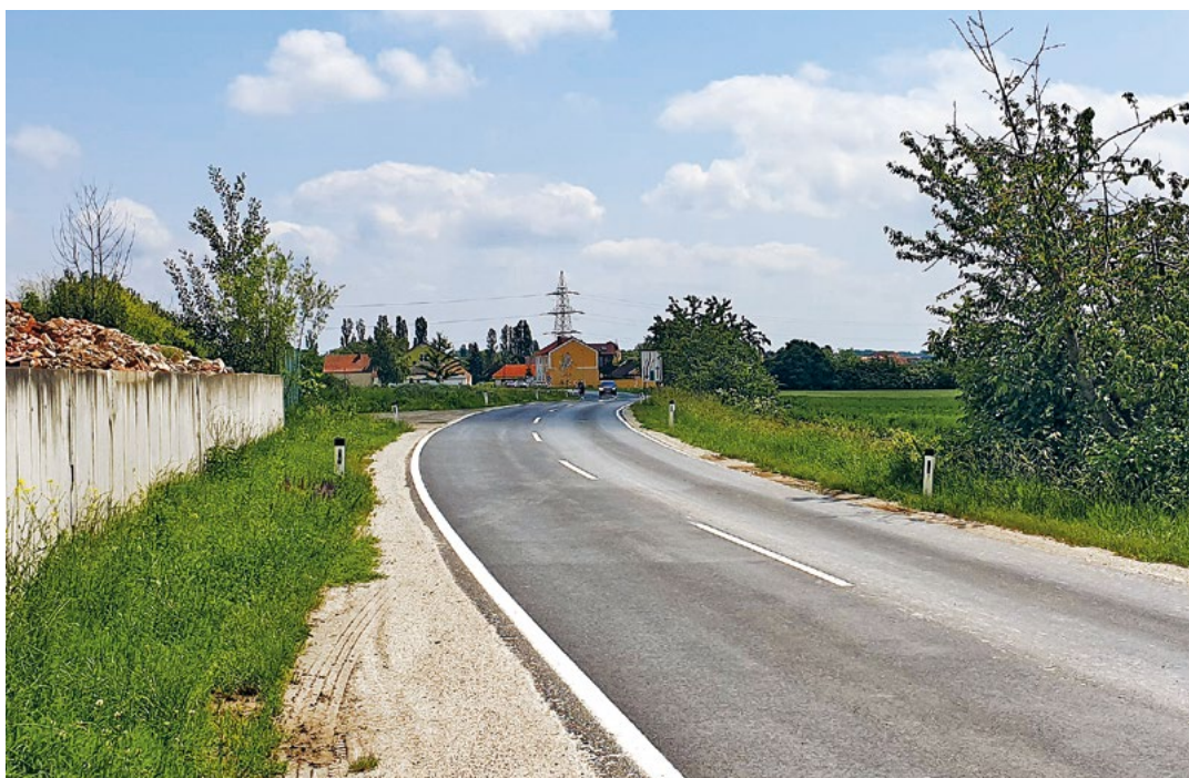
Der Streckenabschnitt vor der Baumaßnahme
