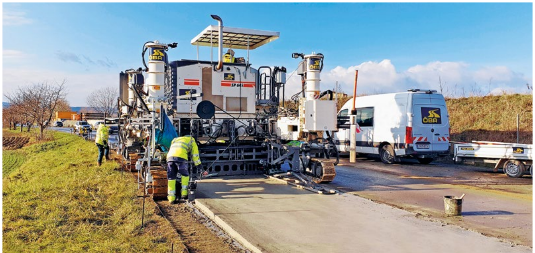
Halbseitiger White- Topping-Einbau mit Betondeckenfertiger
