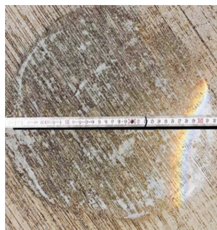
Oberbeton GK 22 mit Besenstrich
