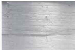
Typ 2: Betonoberfläche mit einheitlicher Struktur
