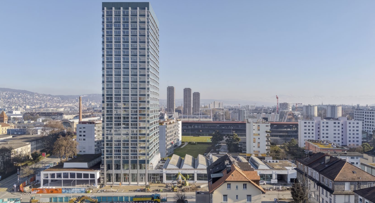
Illustration : vue extérieure de la nouvelle tour ALTO dans la Freihofstrasse, flanquée de la halle à redents existante. Source : Dimitri Dürr.
