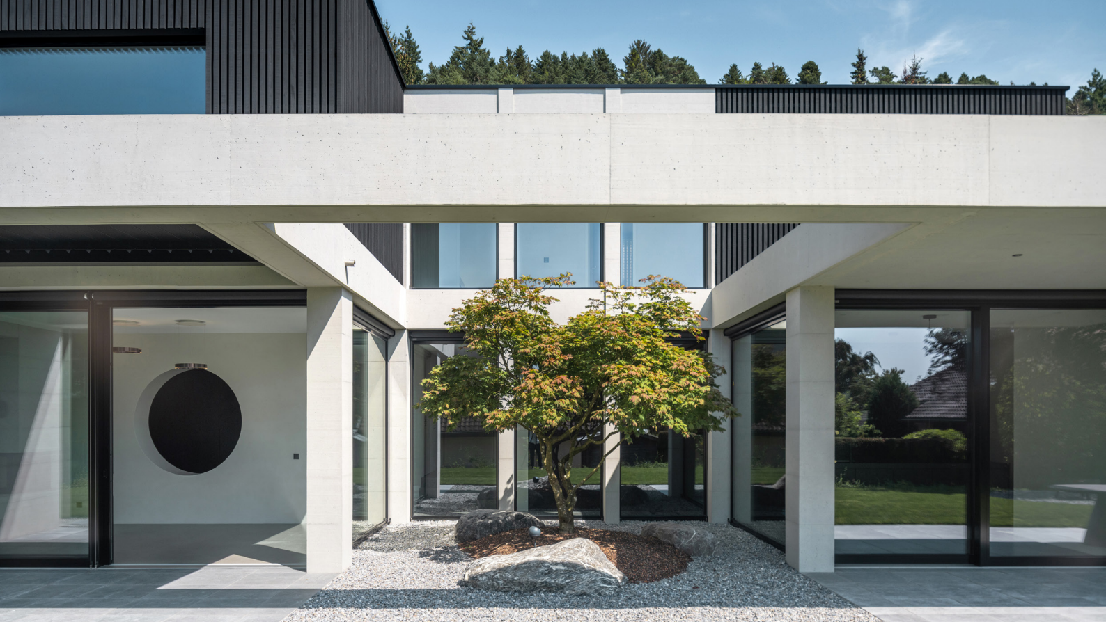
Abbildung: Das Gebäude wirkt im Erdgeschoss durch die massive Sichtbetonfassade robust und monolithisch. Darüber liegt ein Obergeschoss mit vorgehängten, selbsttragenden Holzelementfassaden. Quelle: Kollektiv.w AG
