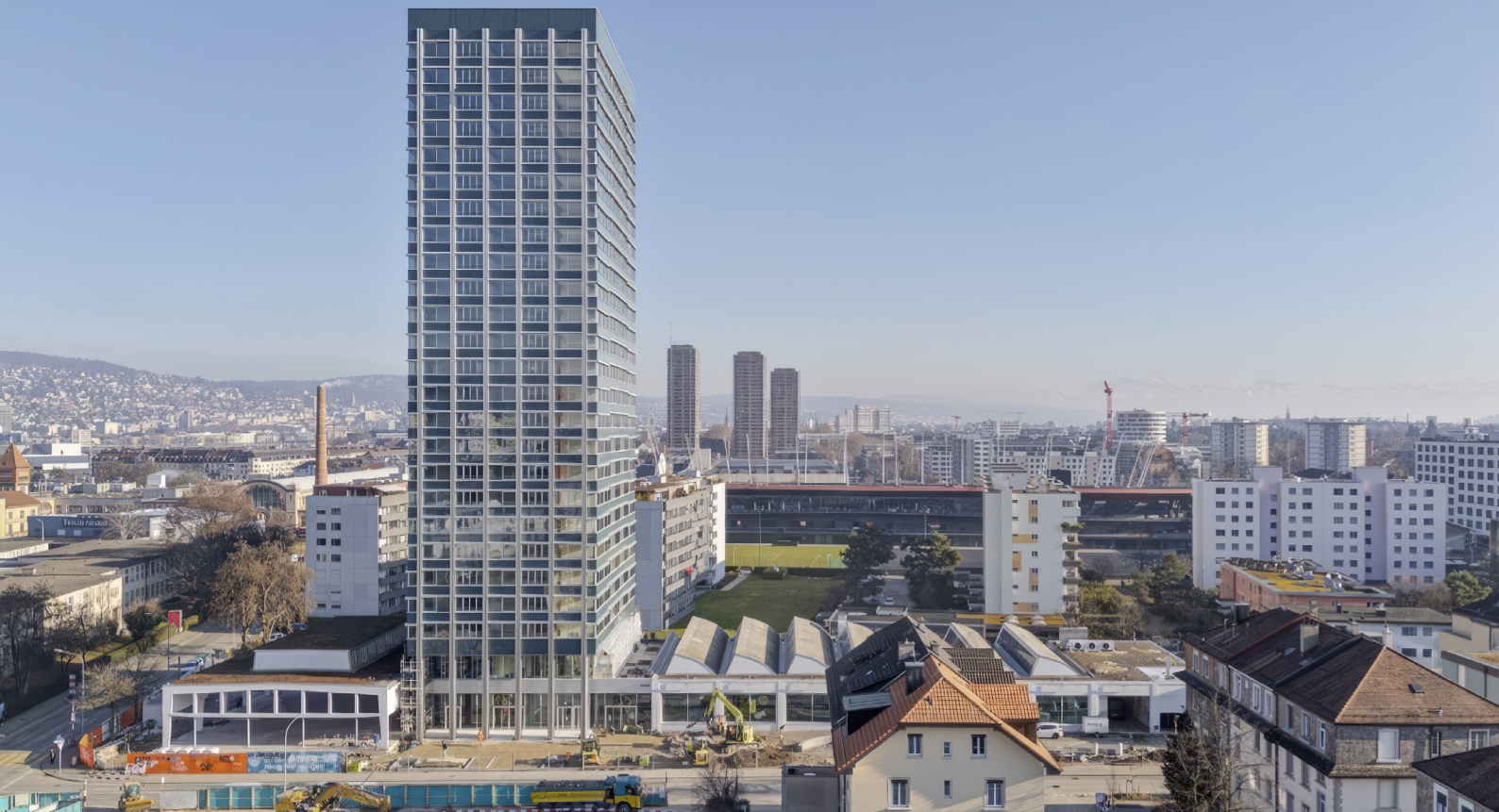
Abbildung: Aussenansicht des neuen Wohnhochhauses ALTO an der Freihofstrasse mit der bestehenden Shedhalle. Quelle: Dimitri Dürr.
