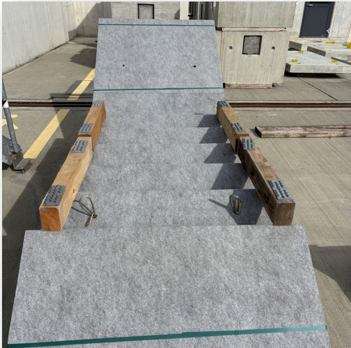
Treppen mit geklebter «Filzfolie»
