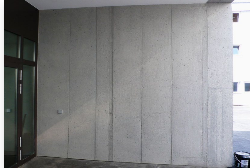
Flickstelle mittels eigenem Verfahren einretuschiert.
