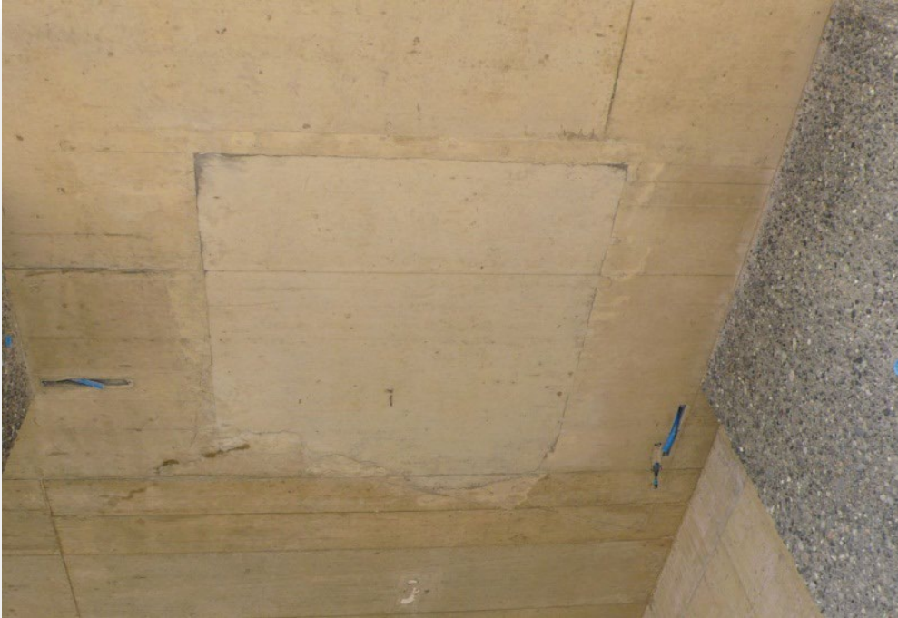
Aussparung an der Decke
