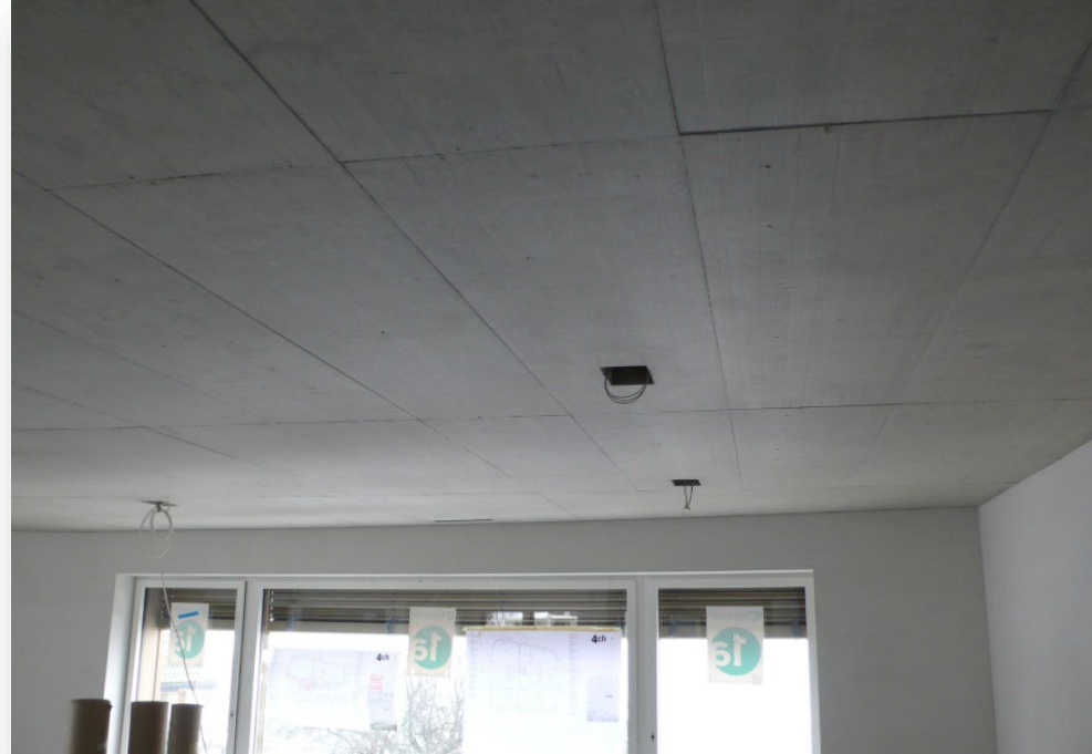
Vollflächige, leicht pigmentierte, matte Überarbeitung
