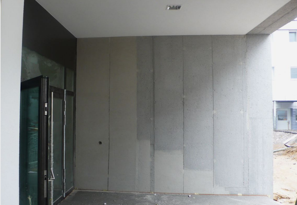
Grosse Ausbrüche nach dem Sandstrahlen. Vollflächig mit Reprofiliermörtel überzogen und nachgestockt.
