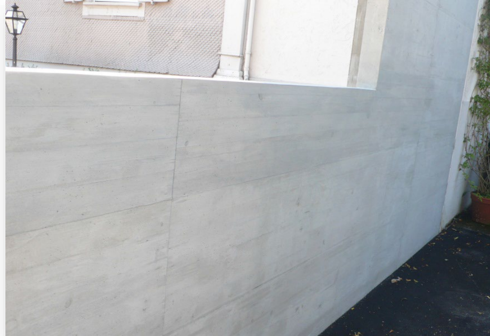
Reprofiliert, fein pigmentiert lasiert und punktuell retuschiert
