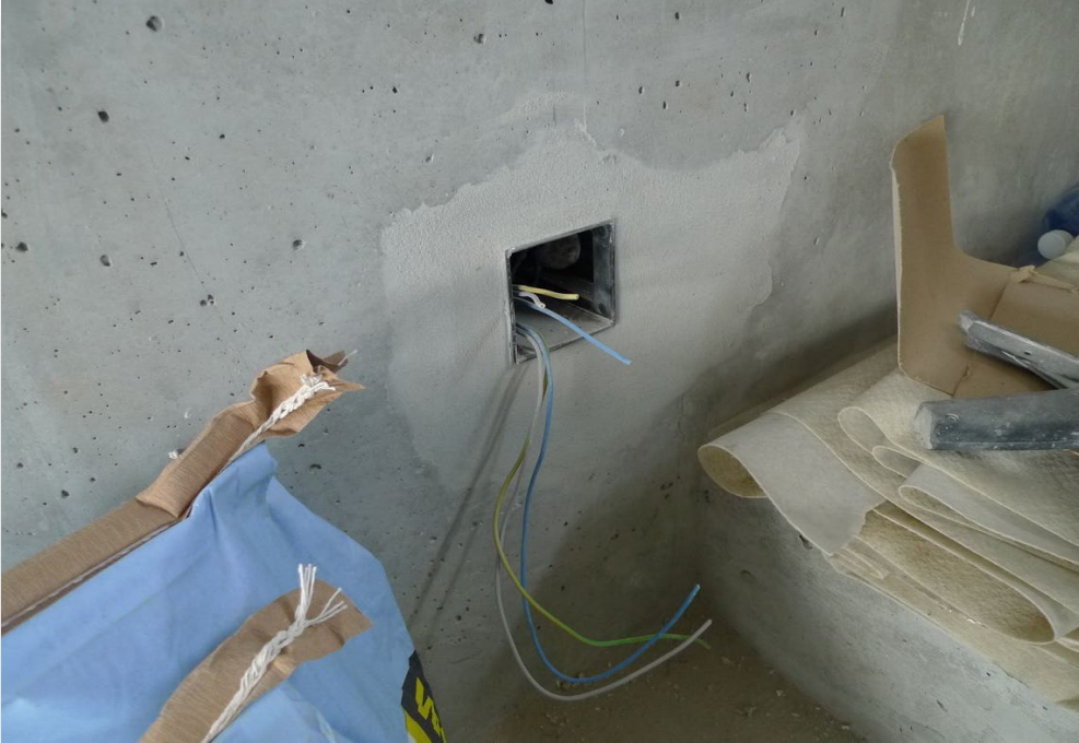
Reprofilierte Lampendose
