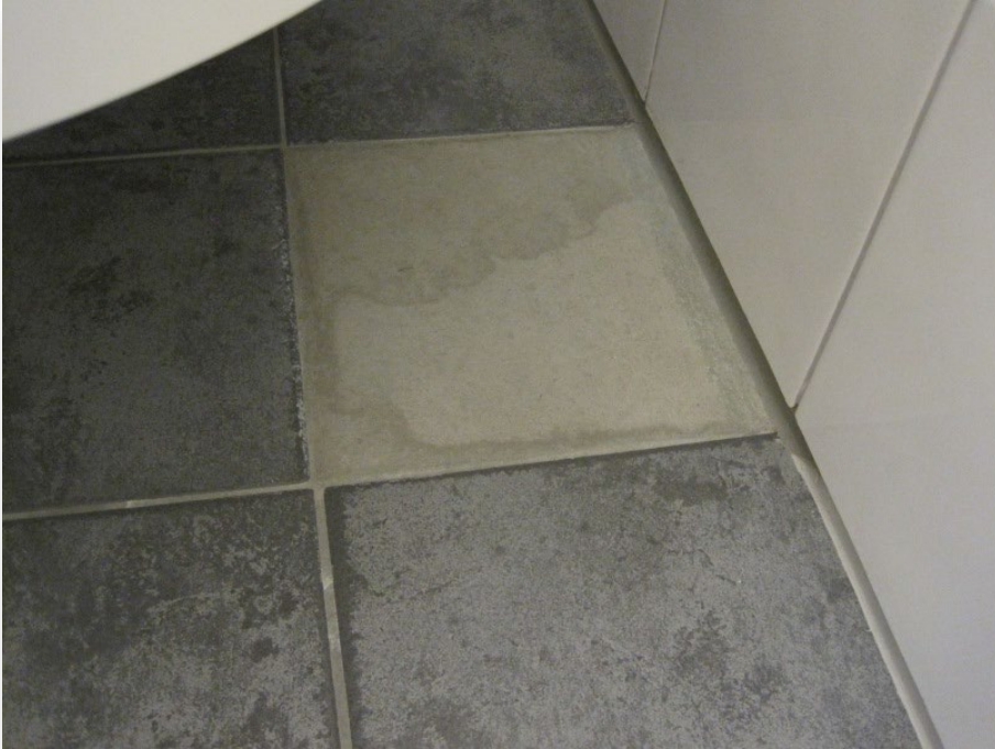
Fehlende Platte mit Kosmetikmörtel reprofiliert
