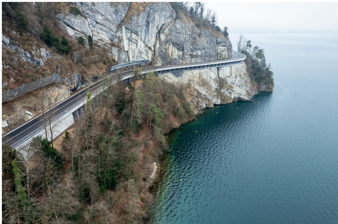
Fig. 1 Gesamtansicht Lehnenkonstruktion Ober Nas. Overall view slope-supported viaduct Ober Nas.
