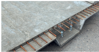
Fig. 7 Stoßfuge zwischen zwei Trogelementen. Butt joint between two trough elements.
