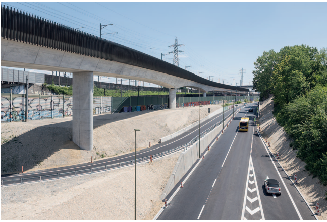
Fig. 2 Donnerbaumbrücke. Donnerbaum bridge. (© Beat Bühler)
