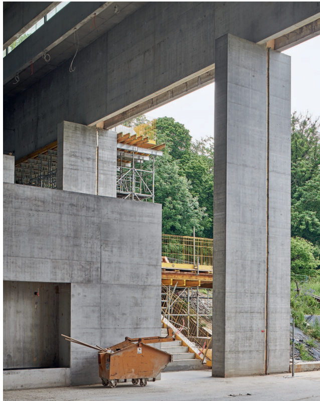
Fig. 9 Die wandartigen Stützen der Dachkonstruktion. The shear wall segments of the roof structure. (© Daniela Tonatiuh)
