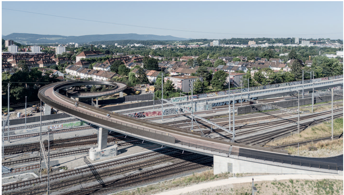
Fig. 7 Passerelle Hagnau. Footbridge Hagnau. (© Beat Bühler)
