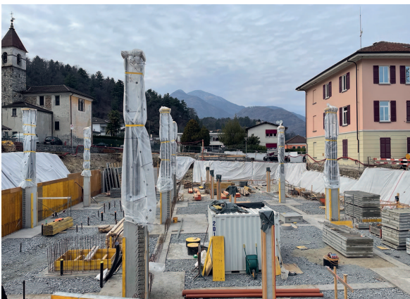
Fig. 7 Il cantiere con le fondazioni e i pilastri del piano interrato. The construction site with the foundations and pillars of the basement.
