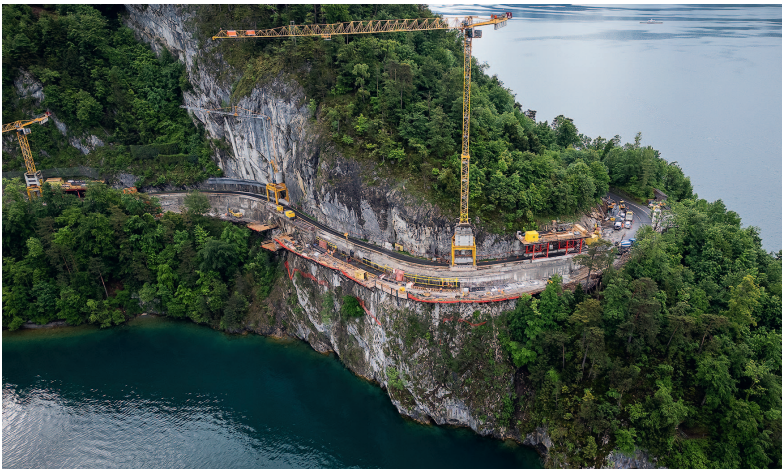
Fig. 8 Baustelleninstallation mit äusserst knappen Platzverhältnissen. Construction site installation with very limited space.
