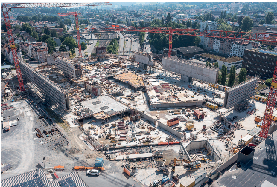
Fig. 5 Luftaufnahme während des Baus. Aerial view during construction. (© Foto-huwi.ch)
