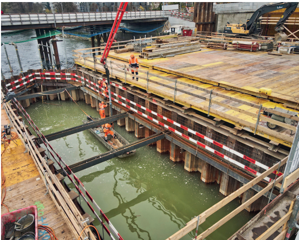
Fig. 7 Spundwandkasten südlicher Pfeiler. Sheet pile box, southern pier. (© WMM Ingenieure AG, Marc Gilgen)
