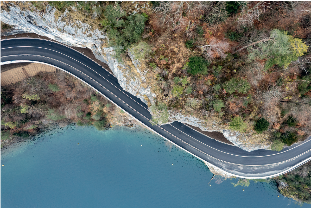
Fig. 2 Lehnenkonstruktion Ober Nas aus der Vogelperspektive. Slope-supported viaduct Ober Nas – bird’s eye view.
