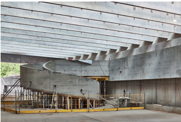
Fig. 7 Innenansicht des Lesesaals im Bauzustand mit der Wendeltreppe. Interior view of the reading room under construction, with the spiral stair. (© Daniela Tonatiuh)
