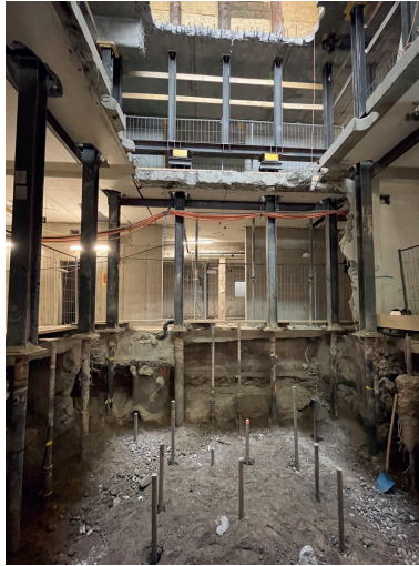
Fig. 7 Abgebrochenes Treppenhaus West mit Notspriessung auf Mikropfählen. Demolished staircase west with temporary supports on micropiles.
