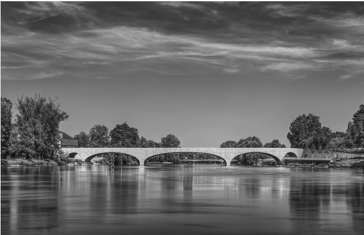
Fig. 10 Gesamtes Brückenbauwerk, Blick flussabwärts. Entire bridge structure, view downstream. (© WMM Ingenieure AG, Luca Ferrario)
