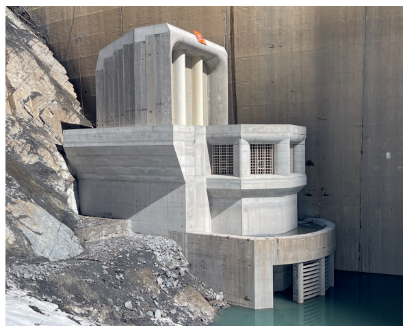
Fig. 3 Gesamtansicht der Erhöhung. General view of the intake raising works.
