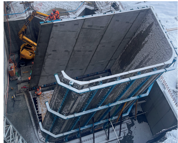
Fig. 5 Ansicht der vorgefertigten Elemente des Schachts. View of the shaft precast elements.
