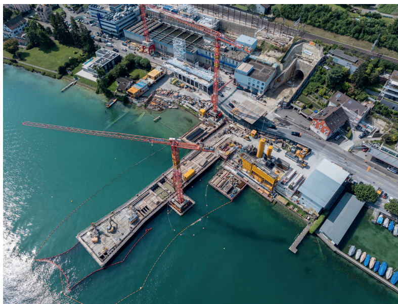
Fig. 6 Luftaufnahme des Stollenmunds (vor Aushub des Tosbauwerks) und der Arbeiten am Auslaufkanal (Aug. 2024). Aerial view of the gallery outlet (prior to excavating the dissipation chamber) and the channel construction (Aug. 2024). (© AWEL)
