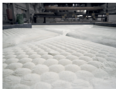
Fig. 7 Nahaufnahme der gedruckten Schalung. Close-up of printed formwork.
