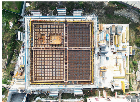
Fig. 8 Il cantiere al termine della posa dei casseri e delle armature del solaio sul piano terreno. The construction site following the completion of the formwork and reinforcement for the ground floor slab.
