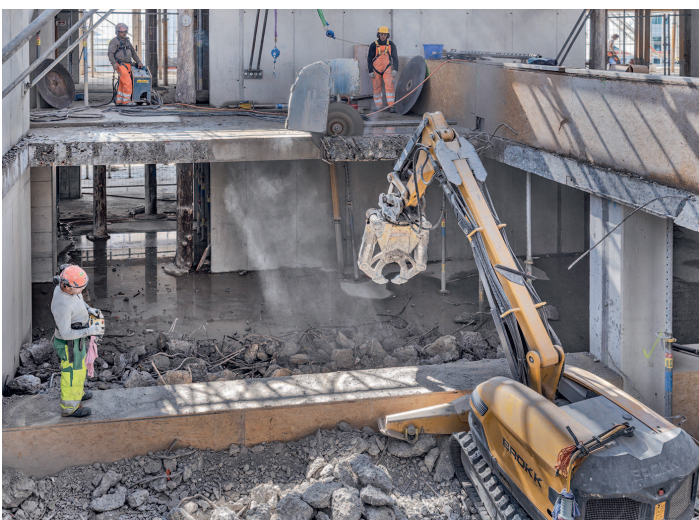
Fig. 3 Abbrucharbeiten im Innenhof. Demolition work in the atrium. (© René Dürr, Zürich)
