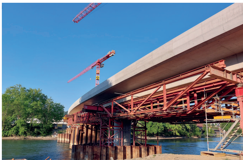
Fig. 8 Lehrgerüst abgesenkt/Betonarbeiten abgeschlossen. Falsework lowered/concrete work completed.
