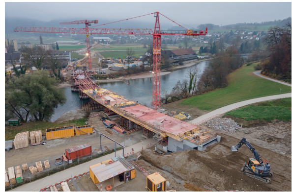
Fig. 7 Erste Überbauetappe betoniert und vorgespannt. First superstructure stage concreted and prestressed.
