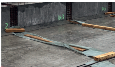
Fig. 8 Ausgiessen der Stoßfuge. Casting the butt joint.
