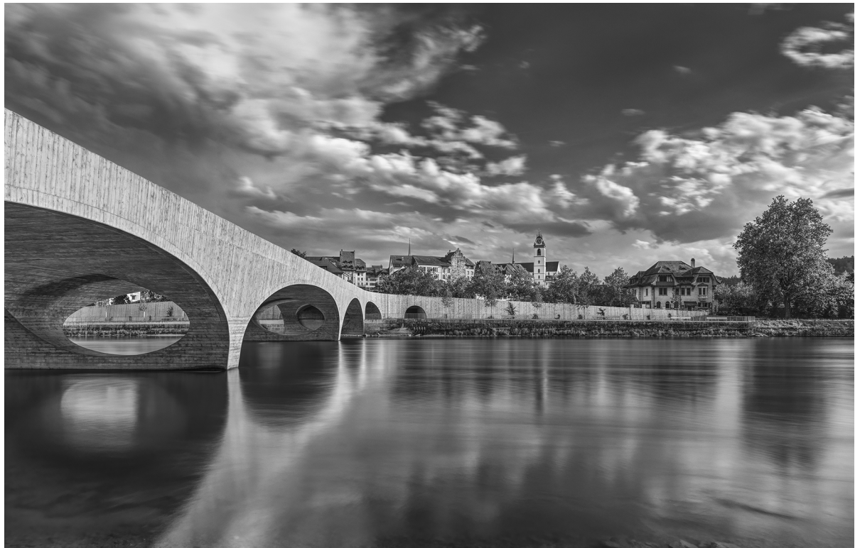
Fig. 9 Oberwasserseitige Flanke und Brückenuntersicht, Blick vom Nordufer in Richtung Süden. Upstream flank and underside of the bridge, view from the north bank towards the south. (© WMM Ingenieure AG, Luca Ferrario)
