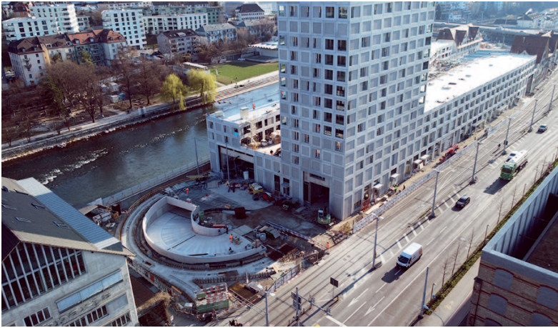
Fig. 2 Einfahrt ins Depot für Tram (im EG) und Fahrrad und Auto (UG) von der Westseite. Entrance to the depot for tram (GF) and bicycle and car (basement) from the west side.
