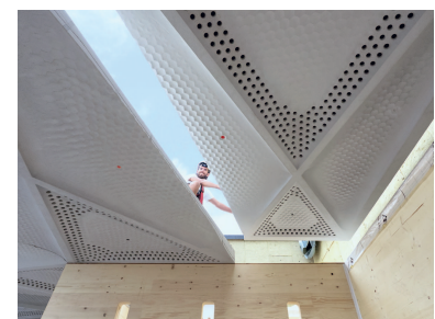
Fig. 8 Versetzen Deckenelemente. Mounting of ceiling element.
