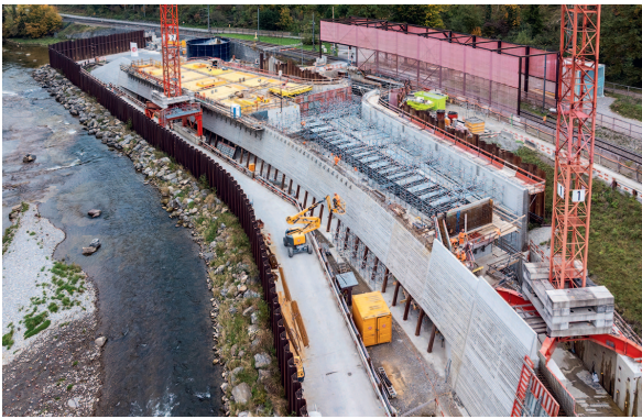
Fig. 2 Einlaufbauwerk im Bau (Okt. 2024) mit architektonisch gestalteter Tauchwand. Intake structure under construction (Oct. 2024) with architecturally designed skimming wall. (© AWEL)
