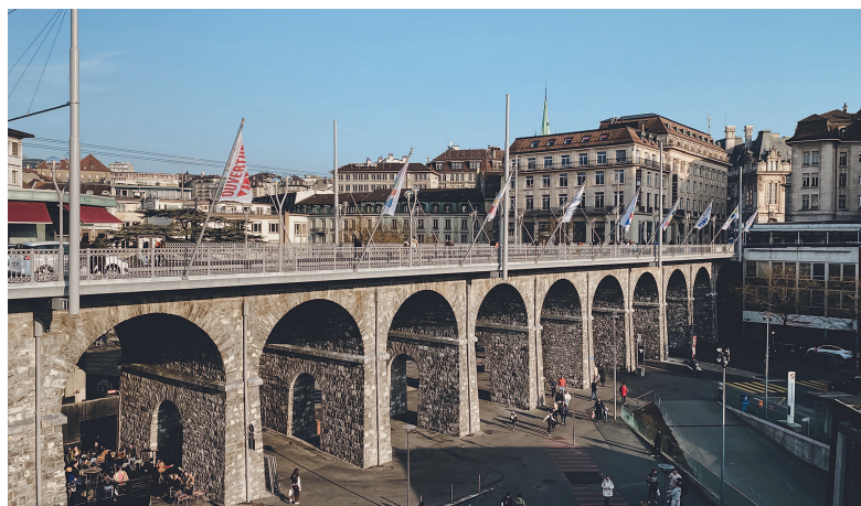
Fig. 6 Vue du pont après les travaux de remise en état. View of the bridge after renovation work.
