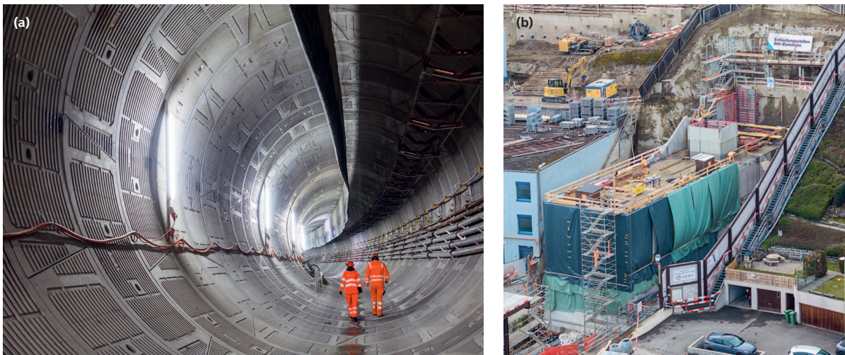
Fig. 5 a) Entlastungsstollen mit gerippten Tübbinggen (Aug. 2024) und b) Betonierarbeiten am Tosbauwerk (Jan. 2026). a) Diversion gallery with ribbed lining segments (Aug. 2024) and b) concreting of the dissipation chamber (Jan. 2026). (© AWEL)
