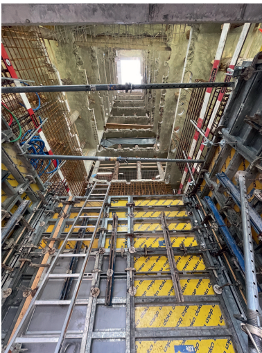
Fig. 8 Neubau Treppenhaus, Logistik mit Kranöffnung. New stairwell, logistics with crane opening.
