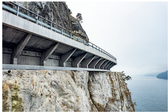
Fig. 4 Die Lehnkonstruktion ist knapp auf dem Felsen aufgelegt. Im Hintergrund die Überbrückung, wo sich das «Streifenfundament» ganz vom Untergrund löst. The slope-supported viaduct is narrowly supported on the rock. In the background, the bridging section where the "strip foundation" completely separates from the subsoil.
