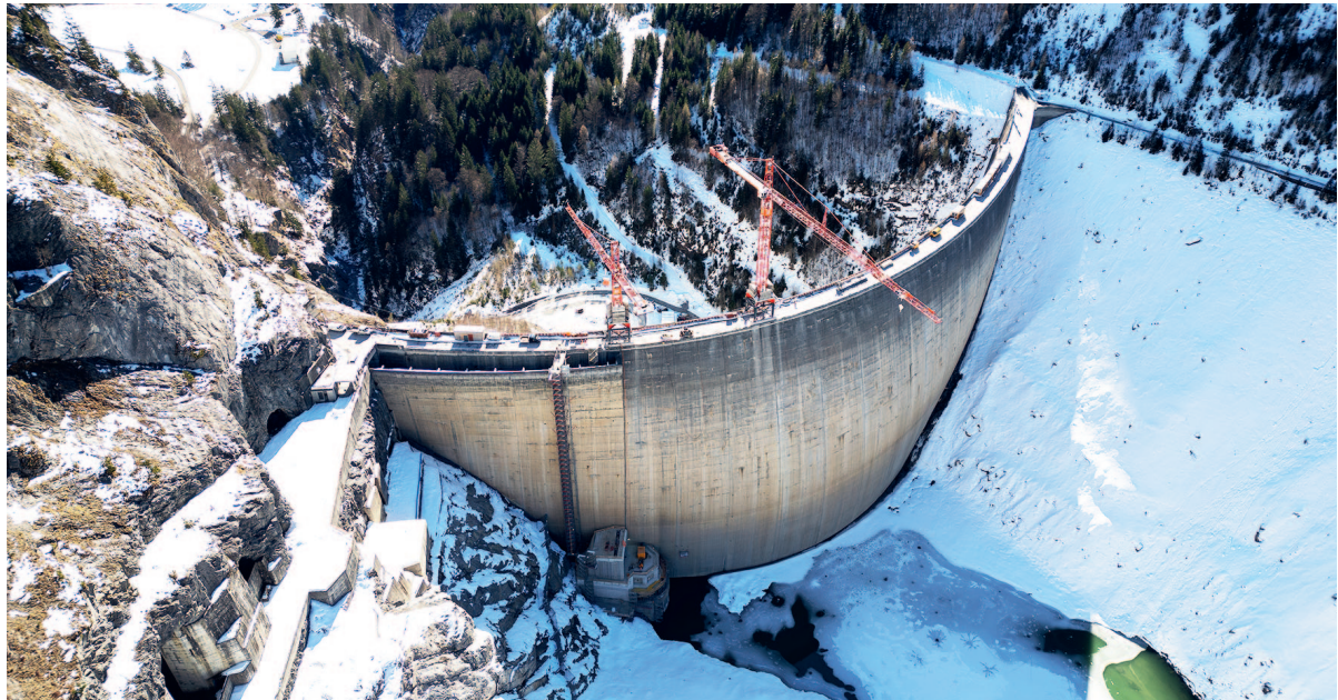
Fig. 1 Gesamtansicht während Bauarbeiten. General view during works.
