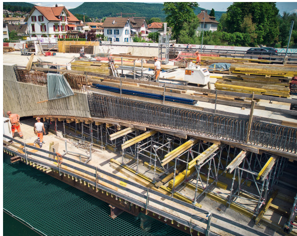
Fig. 8 Bau des Mittelfelds, oberwasserseitig. Construction of the centre field, upstream. (© WMM Ingenieure AG, Marc Gilgen)
