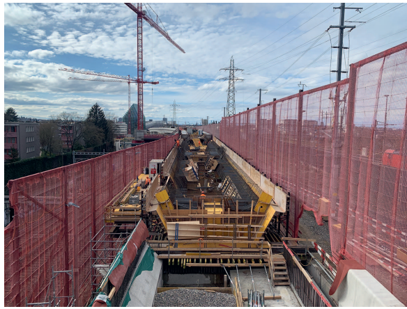
Fig. 6 Erstellung Überbau zwischen den Gleisen. Construction of the superstructure between the tracks.
