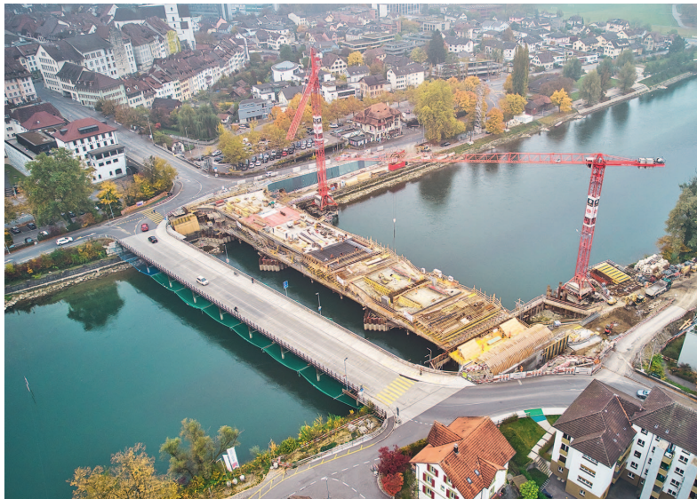
Fig. 6 Luftaufnahme, Blick in Richtung Süden, links die Hilfsbrücke in Betrieb und rechts die neue Brücke im Bau. Aerial view, looking south, the auxiliary bridge in operation on the left and the new bridge under construction on the right. (© WMM Ingenieure AG, Marc Gilgen)
