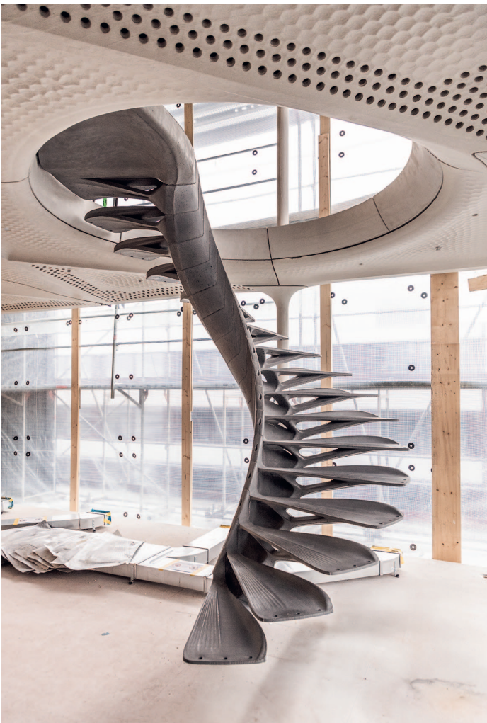
Fig. 16 Treppe Cadenza vor der Montage der Absturzsicherung. Stairs before installation of railing. (© A. Jipa, Digital Building Technologies, ETH Zürich)
