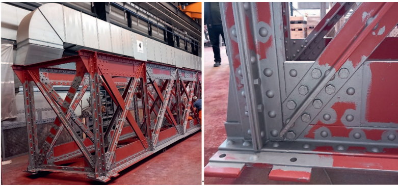
Fig. 10 Erneuerung des Korrosionsschutzes des Stahlfachwerkträgers. Renewal of the corrosion protection of the steel truss girder.
