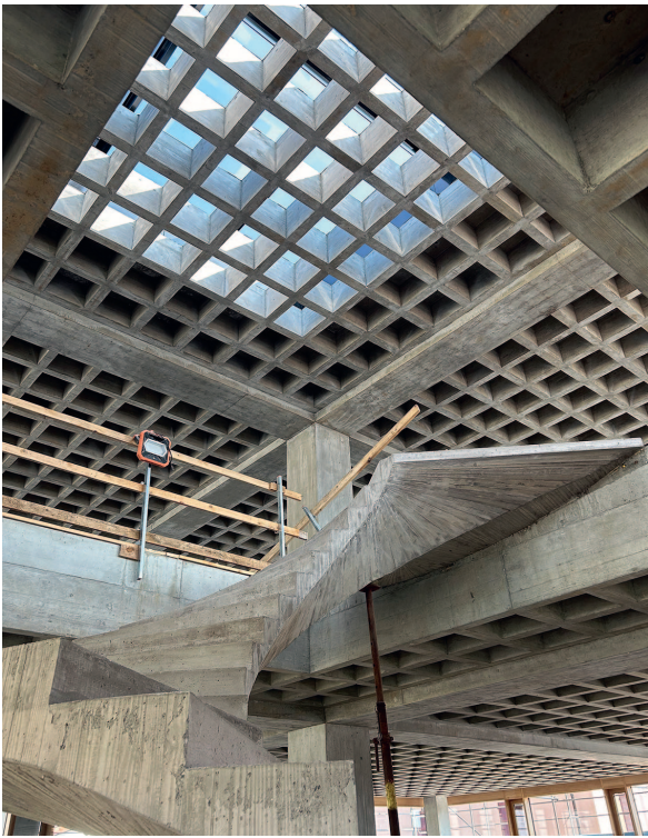
Fig. 11 Il pianerottolo della scala al secondo piano e il solaio di copertura a struttura ultimata. The landing on the second-floor staircase and the roof slab once structure completed.
