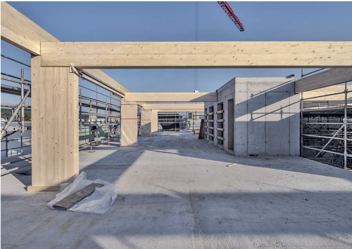
Fig. 6 Die Aufstockung erfolgte in Holzbauweise. The extension was constructed using timber. (© René Dürr, Zürich)
