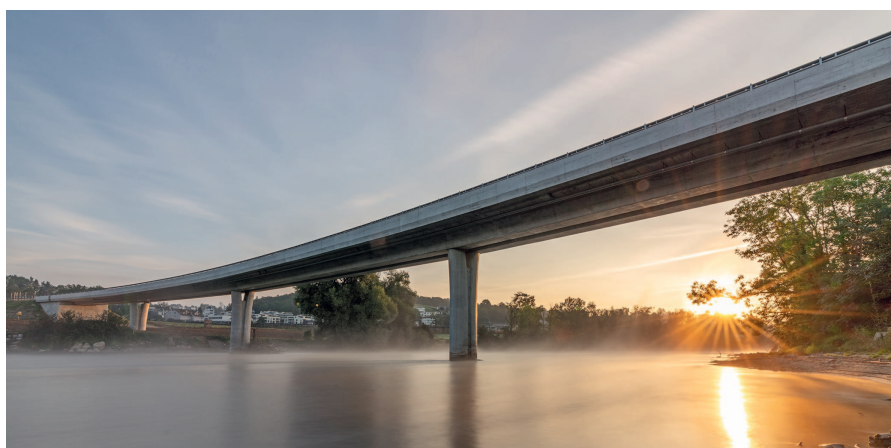
Fig. 1 Umfahrung Mellingen, neue Reussbrücke. Mellingen bypass, new Reuss bridge.
