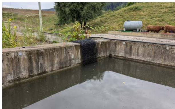
Aide à la sortie pour amphibiens en géotextile dans un bassin bétonné
