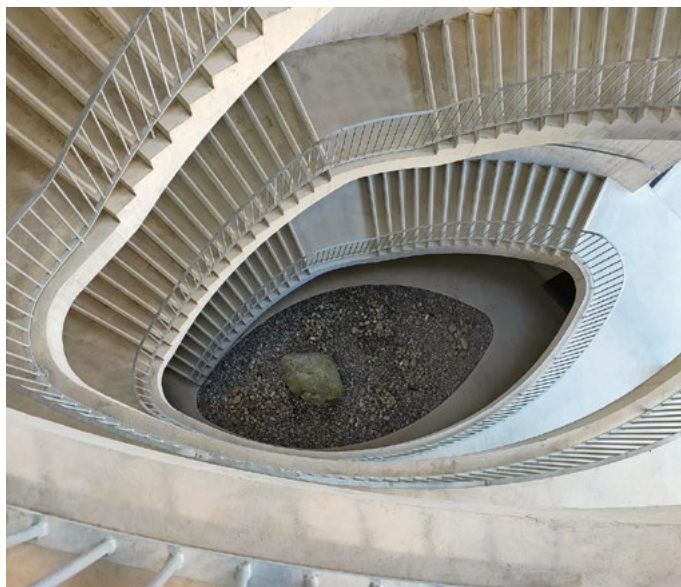
Offenes Treppenauge mit Regenwasserversickerung.
