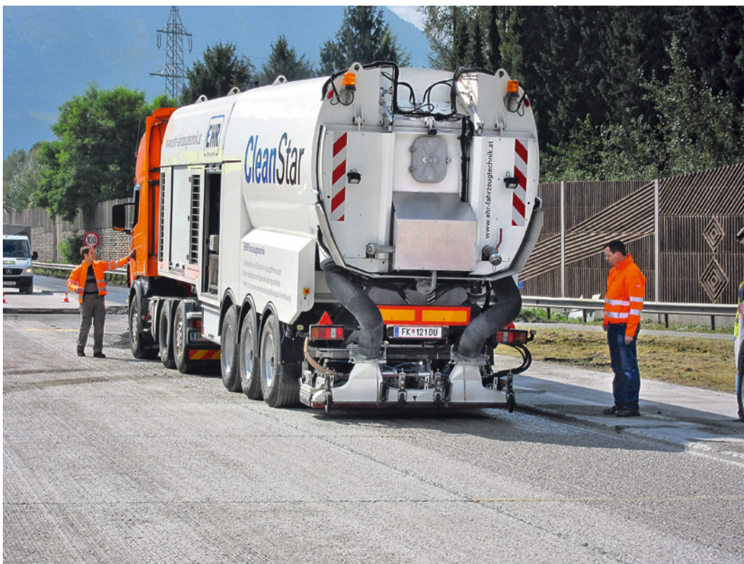
Abb. 6 Reinigung mittels Höchstdruckwasserstrahlen (HDW)
