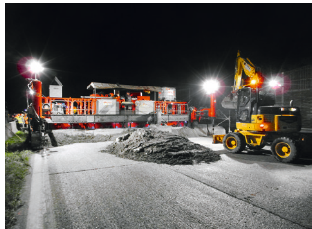
Abb. 8 Betondeckeneinbau bei Nacht
