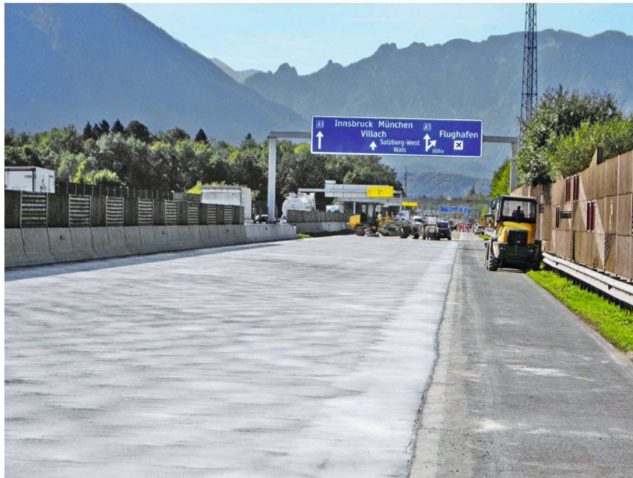
Fig. 9 Revêtement en béton après son assainissement
