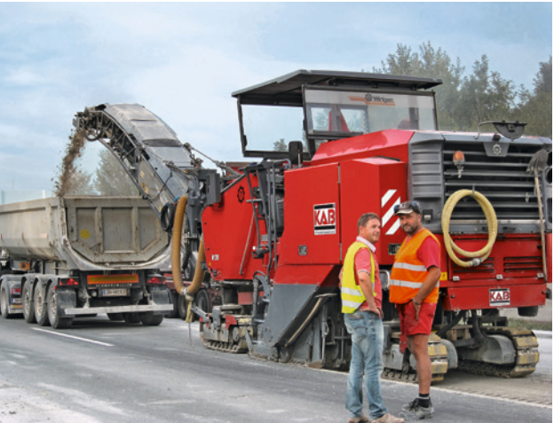
Fig. 3 Enlèvement à la fraiseuse d'une couche de 8 cm
