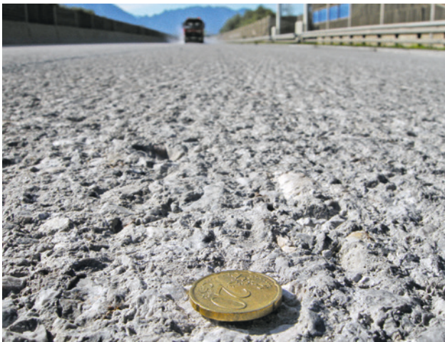
Fig. 5 Surface après nettoyage au HDW
