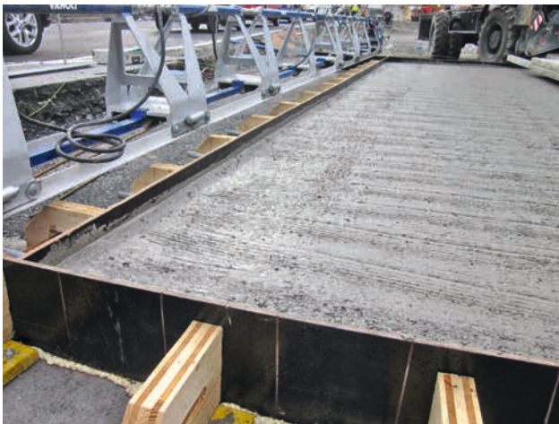
2. Structuration de la surface de béton encore fraîche
