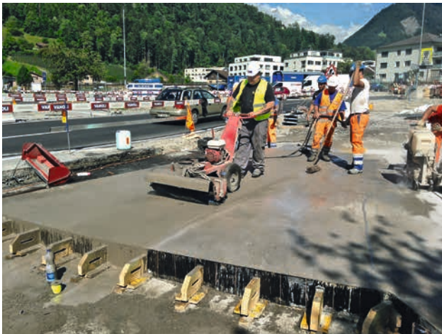
7. Brossage du béton en surface et nouvelle application d'un produit contre l'évaporation (curing)
