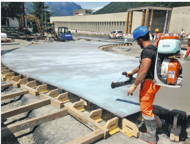
5. Épandage d'un adjuvant composite (retardateur et curing)
