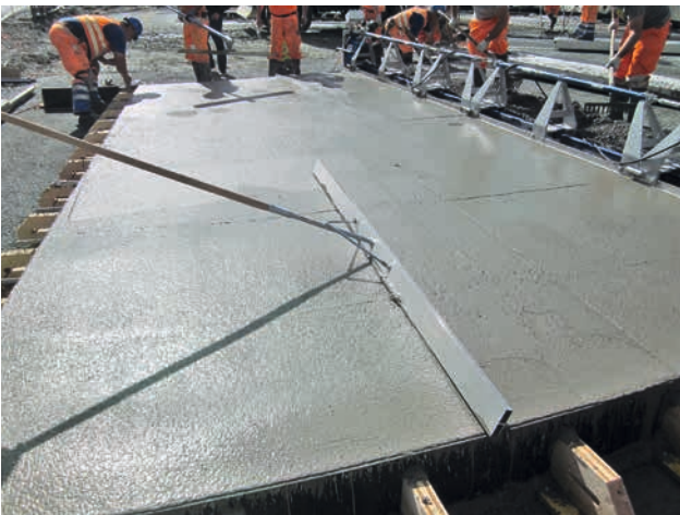
4. Égalisation et contrôle de la planéité
