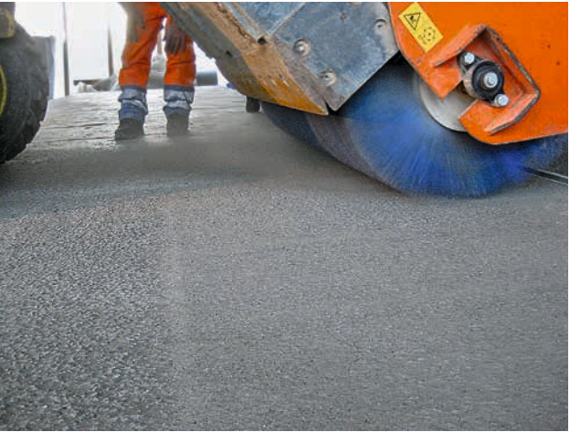
Brossage de la surface
