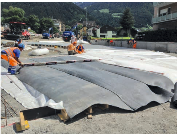
6. Protection par pose d'un non-tissé et / ou d'une natte
