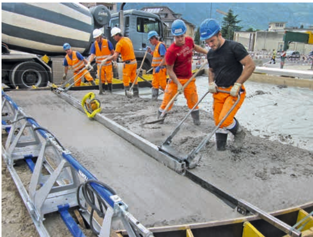
1. Mise en place du béton inférieur, ép. 20 cm
