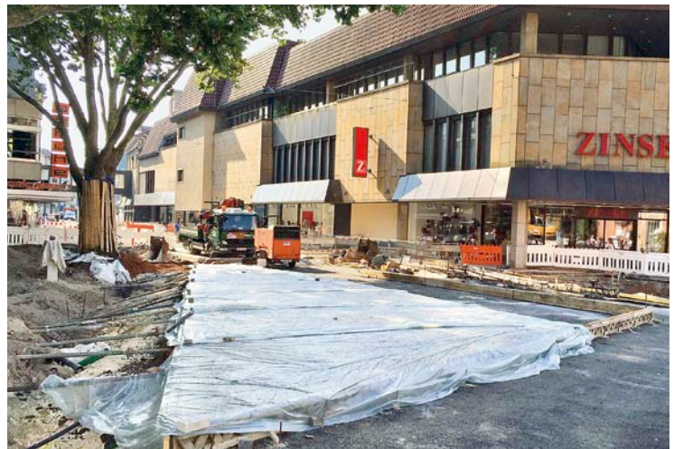
Abb. 10: Einpacken der Betonflächen mit Folie (Nachbehandlung)
