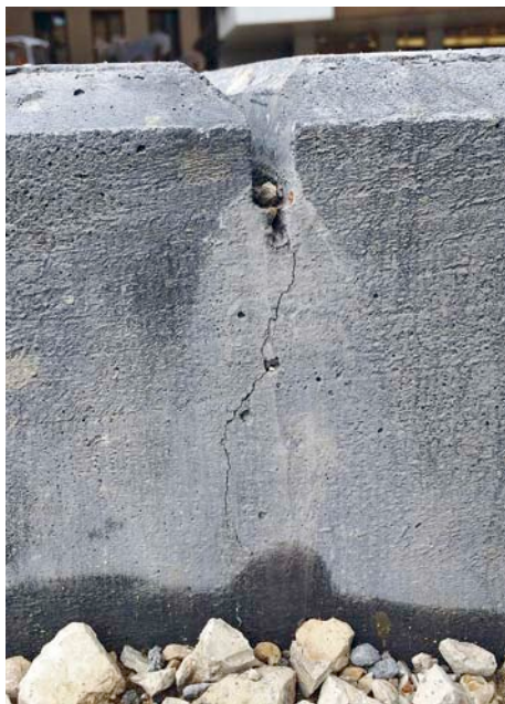
Abb. 5: Scheinfuge mit Voute und geplantem Riss
