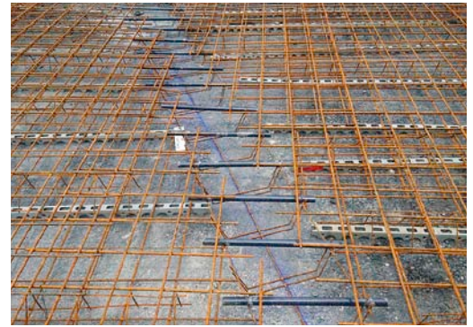
Abb. 6: Dübel in schrägverlaufender Fuge
