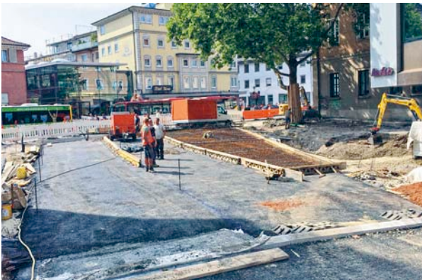
Abb. 2: Unterbau (Asphalttragschicht)
