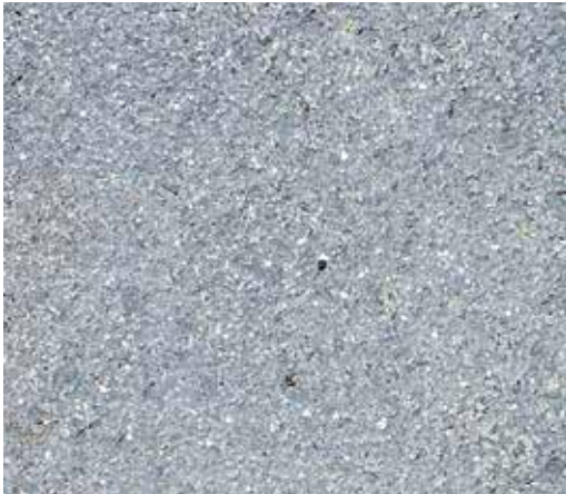
Illustration 13: surface de béton «bouchardée»
