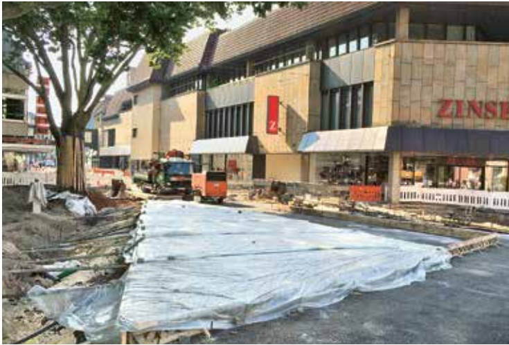
Illustration 10: recouvrement des surfaces bétonnées par un film (cure)
