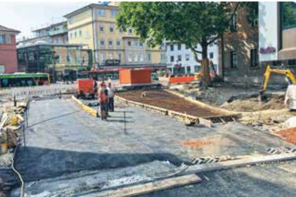
Illustration 2: infrastructure (couche de base en asphalte)
