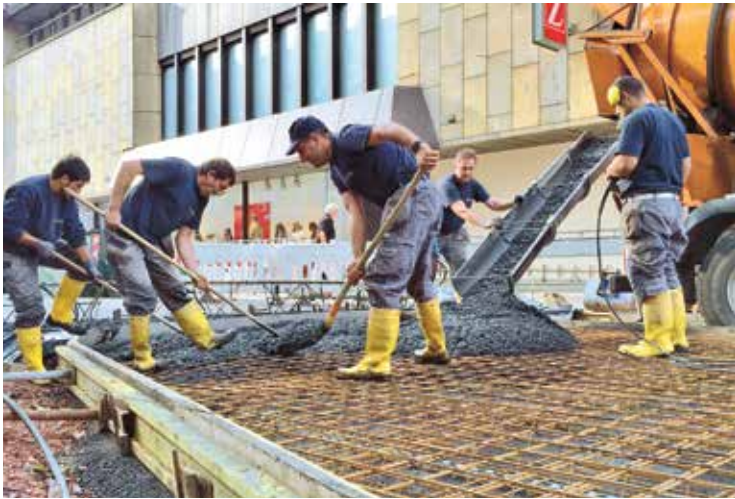
Illustration 9: bétonnage
