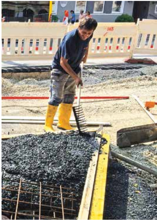
Illustration 8: bétonnage
