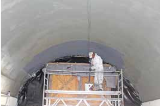
Illustration 7 : mise en place des états d'évaluation dans le tunnel d'essai aménagé a. Pose du revêtement en béton b. Pose des dalles de bordure c. Installation des lampes d. Peinture de la coque intérieure du tunnel avec peinture de la voûte (source : SMG)
