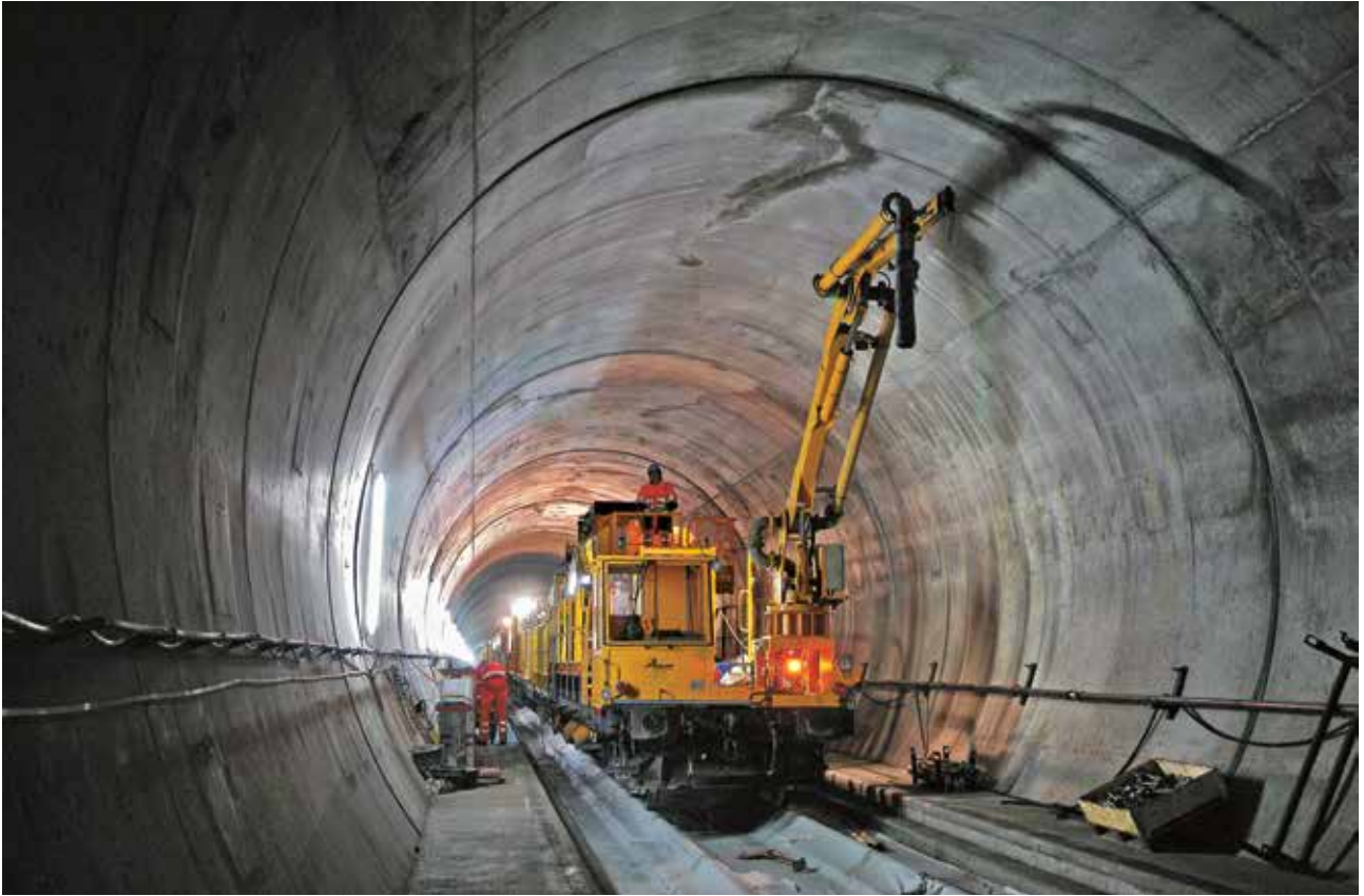
Abbildung 12: Der Pumpenwagen am Kopfende des Betonzuges © TTG
