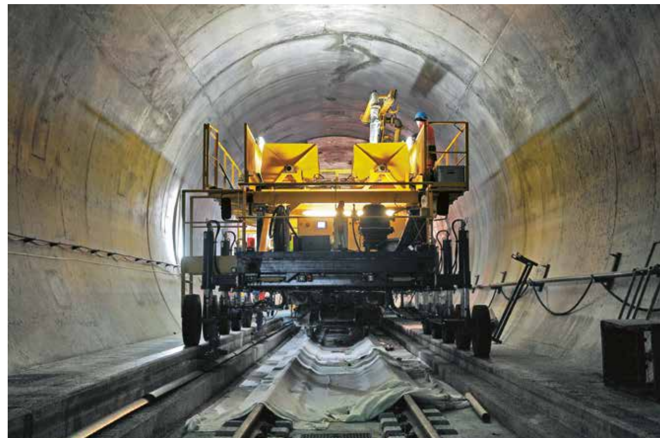
Illustration 13 : le transporteur de béton circule sur la banquette © TTG
