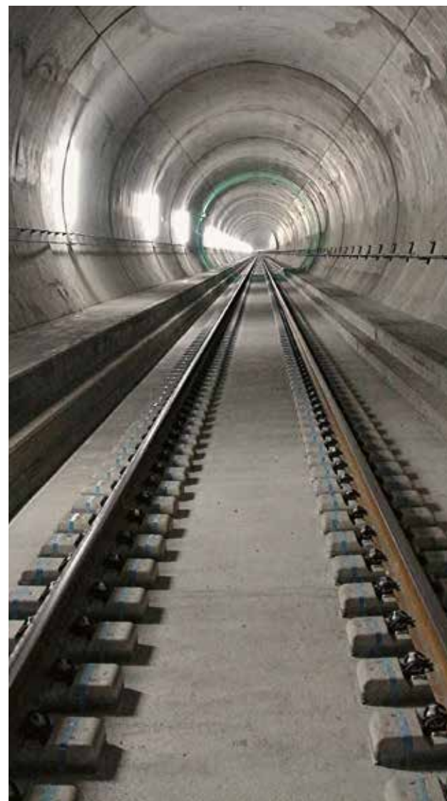
Illustration 2 : voie sur dalle de béton achevée dans le tronçon Faïdo-Bodio ouest © TTG
