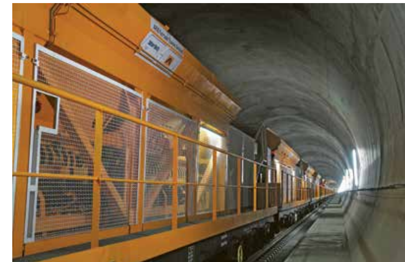
Illustration 11 : les wagons du train de bétonnage transportant les agrégats © AFTTG
