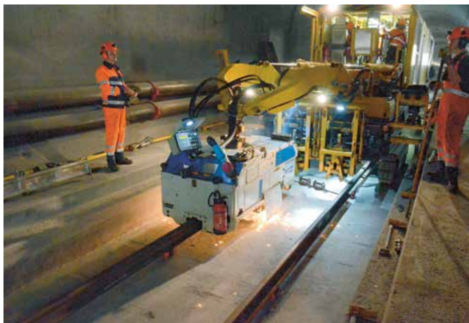
Illustration 7 : déchargement des rails Illustration 8 : alignement des rails avant le soudage Illustration 9 : soudage des rails en bout par étincelage Illustration 10 : les machines de construction de voies ferrées © AFTTG
