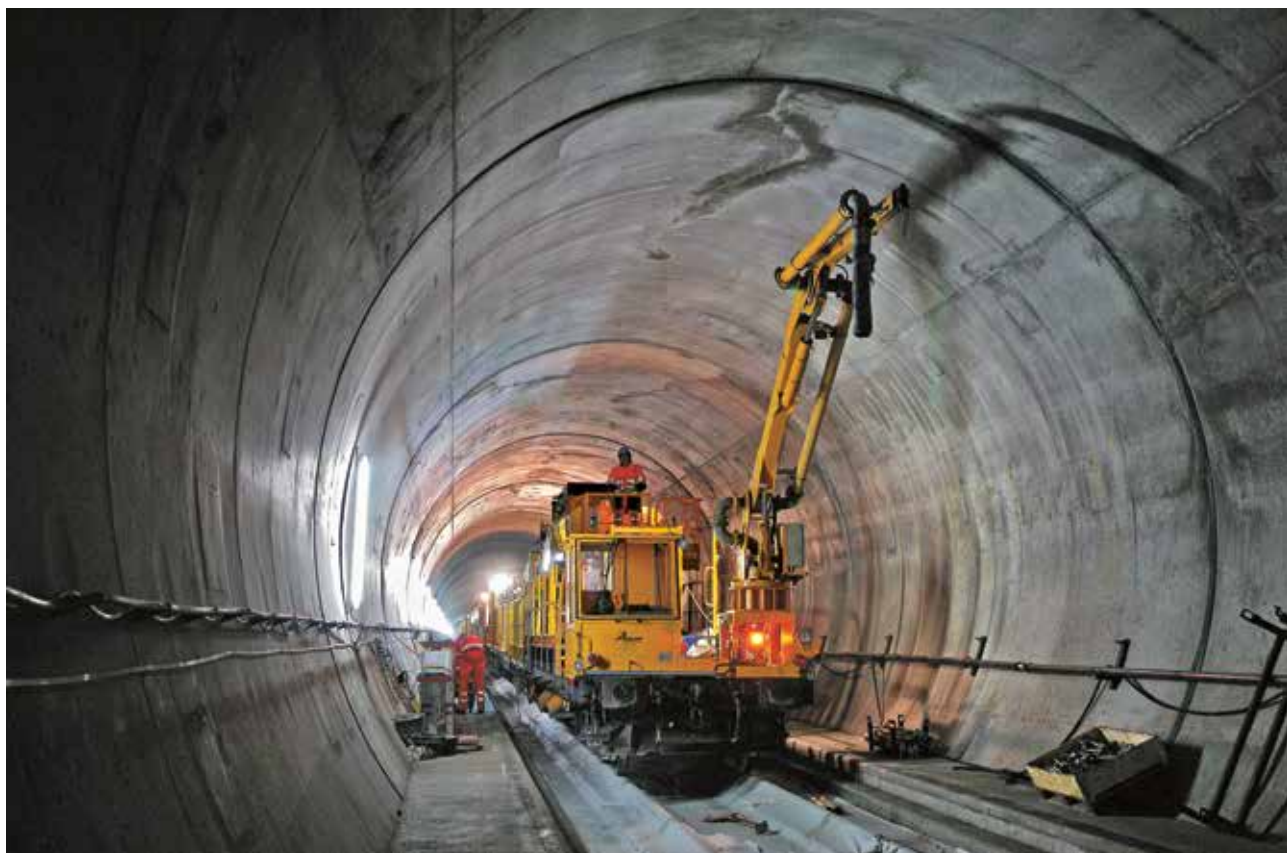
Illustration 12 : le wagon-pompe à l'extrémité de tête du train de bétonnage © TTG
