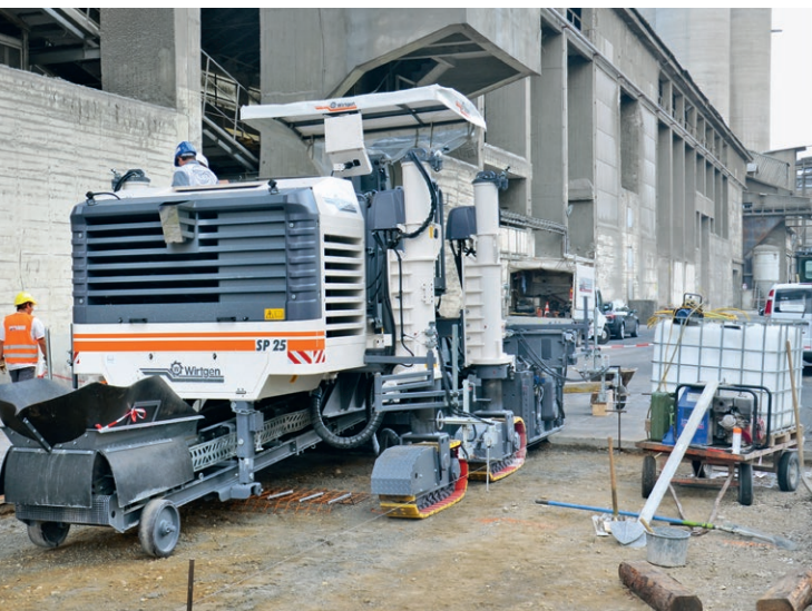
Abbildung 3: Situation bei einseitiger Verkehrsführung Abbildung 4: Gleitschalungsfertiger
