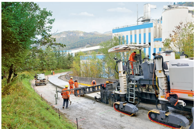
Abbildung 17: Einbau in steilem Gelände
