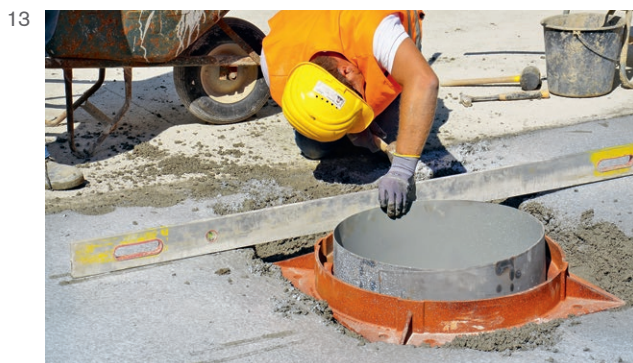
Abbildung 11: Freilegen des Schachtes Abbildung 12: Anschlussstück einlegen + Schutzring einklemmen Abbildung 13: Anschlussstück horizontieren Abbildung 14: Manuelles Glätten der Betonoberfläche Abbildung 15: Auskehren der Waschbetonoberfläche Abbildung 16: Fertige Betonstraße
