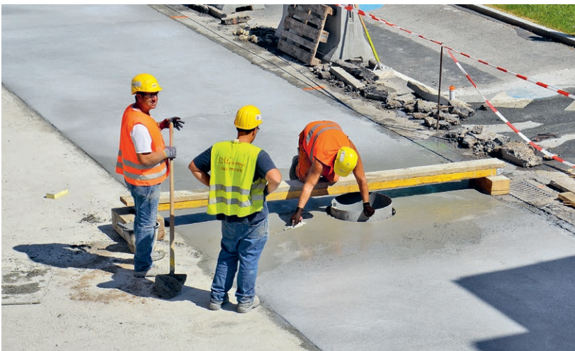
Abbildung 11: Freilegen des Schachtes Abbildung 12: Anschlussstück einlegen + Schutzring einklemmen Abbildung 13: Anschlussstück horizontieren Abbildung 14: Manuelles Glätten der Betonoberfläche Abbildung 15: Auskehren der Waschbetonoberfläche Abbildung 16: Fertige Betonstraße
