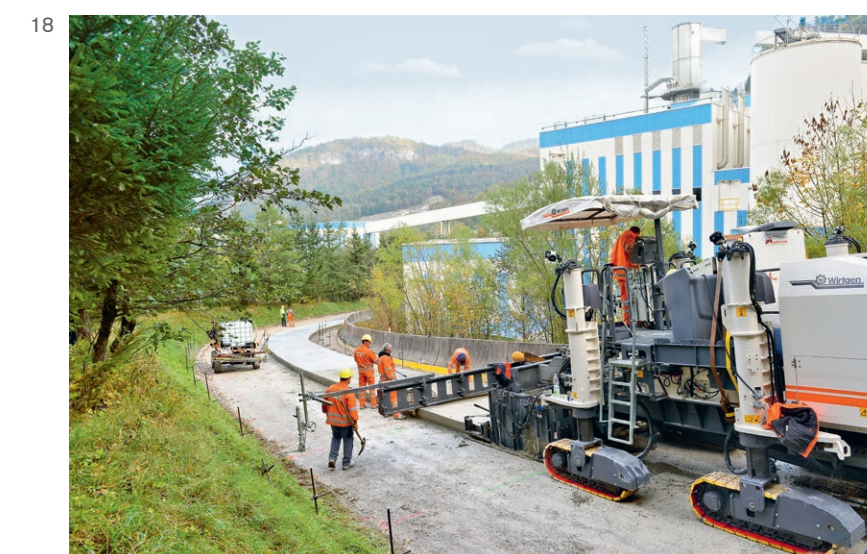
Illustration 17 : mise en place sur terrain en pente Illustration 18 : mise en place sur un terrain en pente et sinueux
