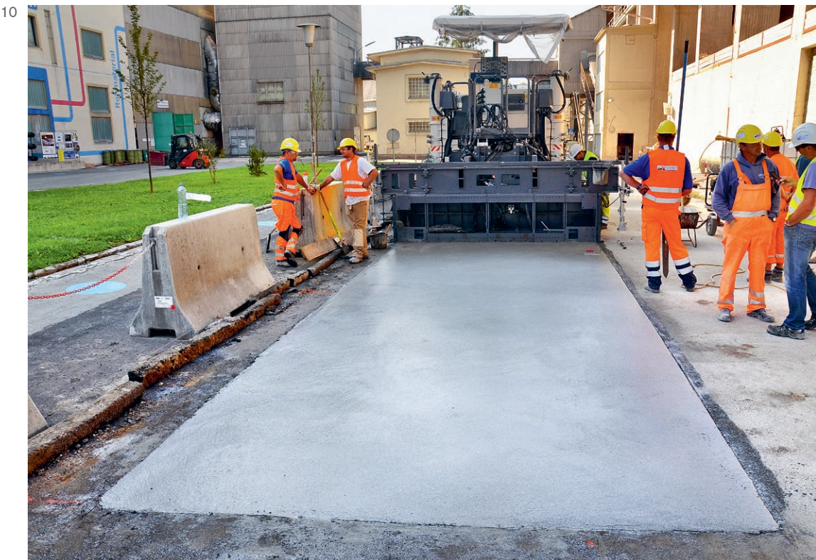
Illustration 5 : unité de mise en œuvre Illustration 6 : angle vif Illustration 7 : panier de goudjons préfabriqués (ÖBA – F. Lecker) Illustration 8 : entailles et ancrages forés (trois par zone) Illustration 9 : passage asymétrique du finisseur dans la largeur de la zone Illustration 10 : cure immédiate
