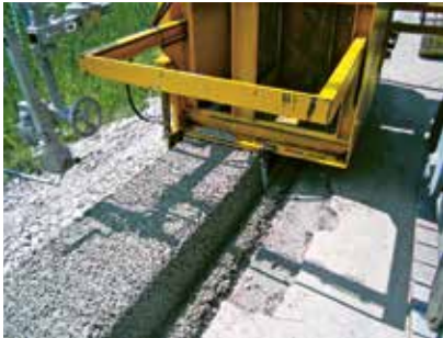
K1259 Kleinbettlingen–Grafenberg (BW) Réalisation de la bande dérasée en béton avant mise en œuvre d'un nouveau revêtement bitumeux
