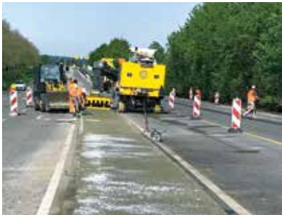
K1073 Sindelfingen–Dagersheim (BW) Stabilisation du terre-plein en béton d'accotement
