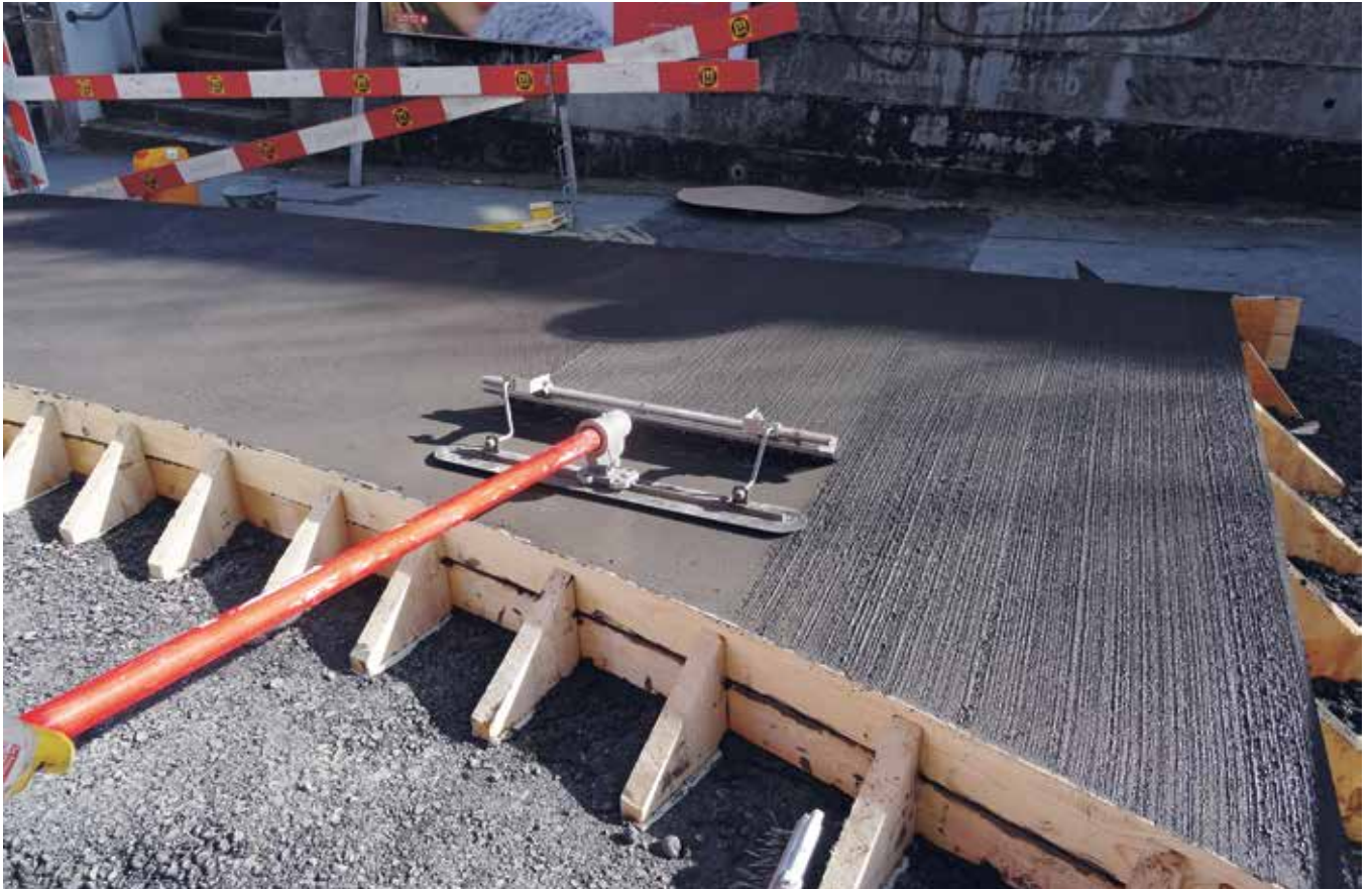
Aufräumen der Oberfläche mit dem Besen (oben) und Verkehrsinsel mit geklebten Randabschlusssteinen (rechts).
