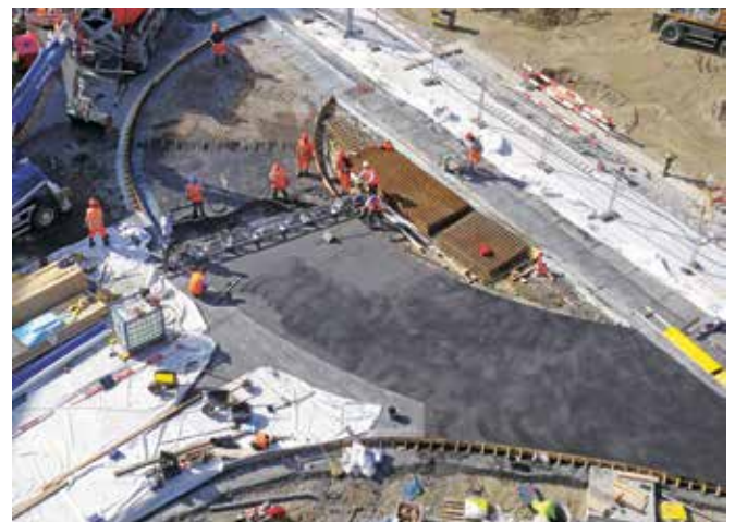
Abziehen der Oberfläche mit dem Vibrationsbalken.
