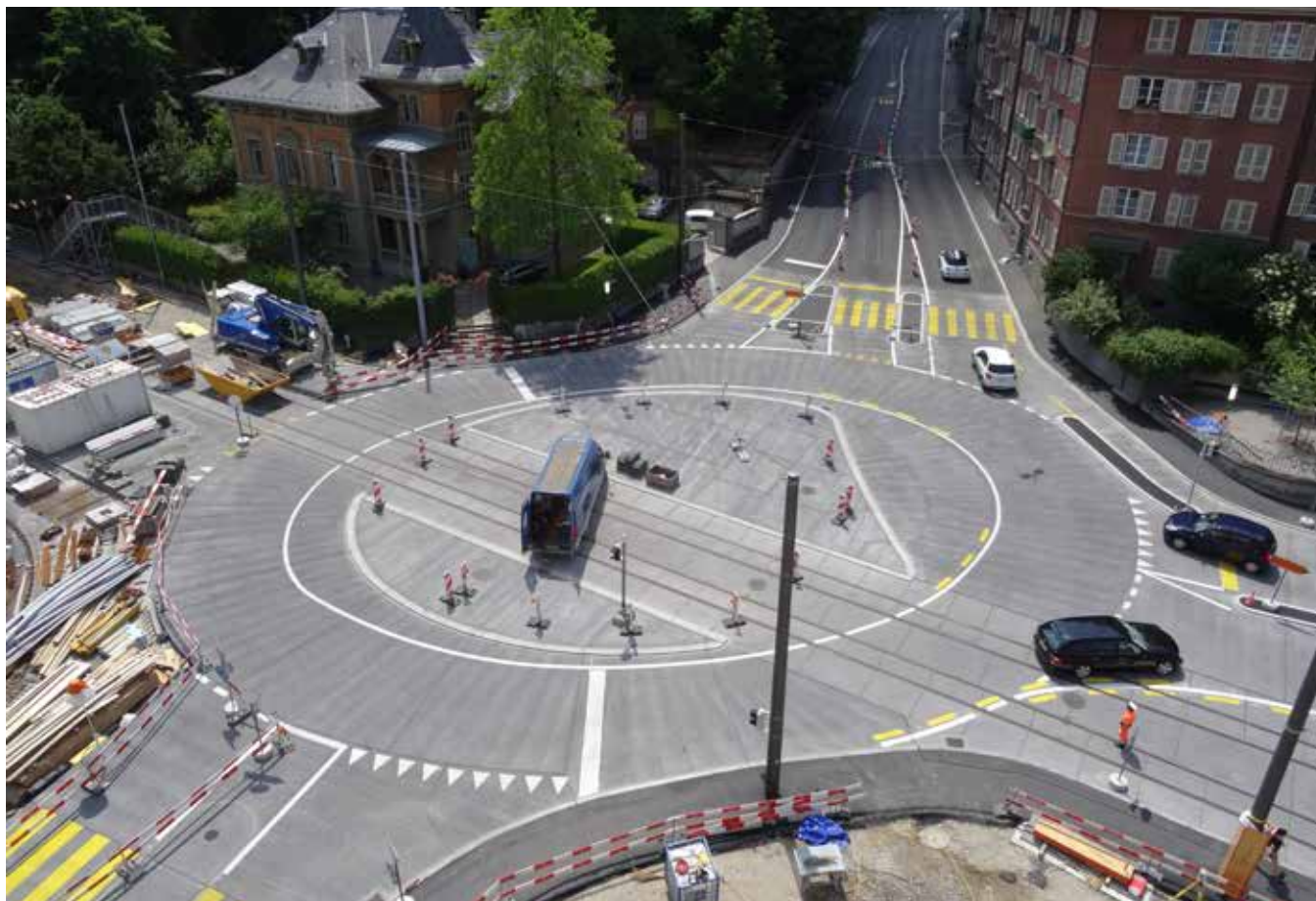
Travaux d'achèvement et de jointoyage sur le nouveau giratoire en béton.
