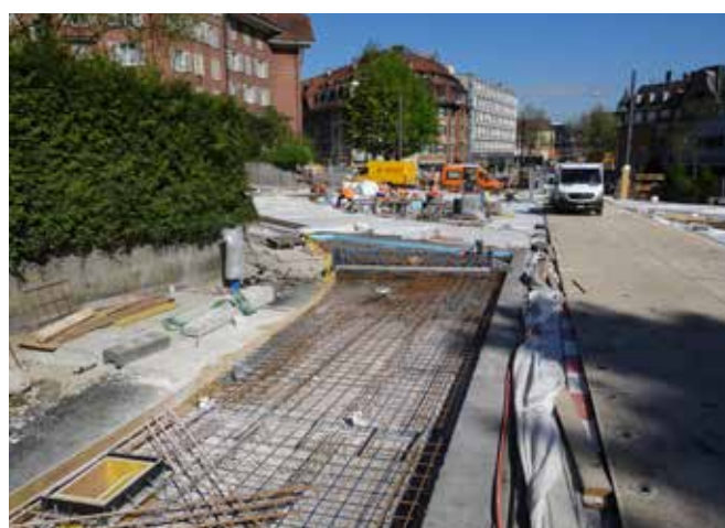
Bétonnage de la troisième étape.
