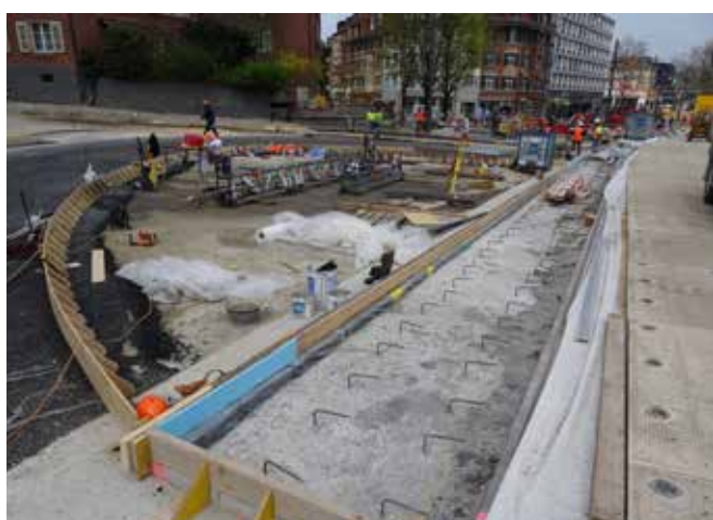
Bétonnage des bords de la voie en adhérence.
