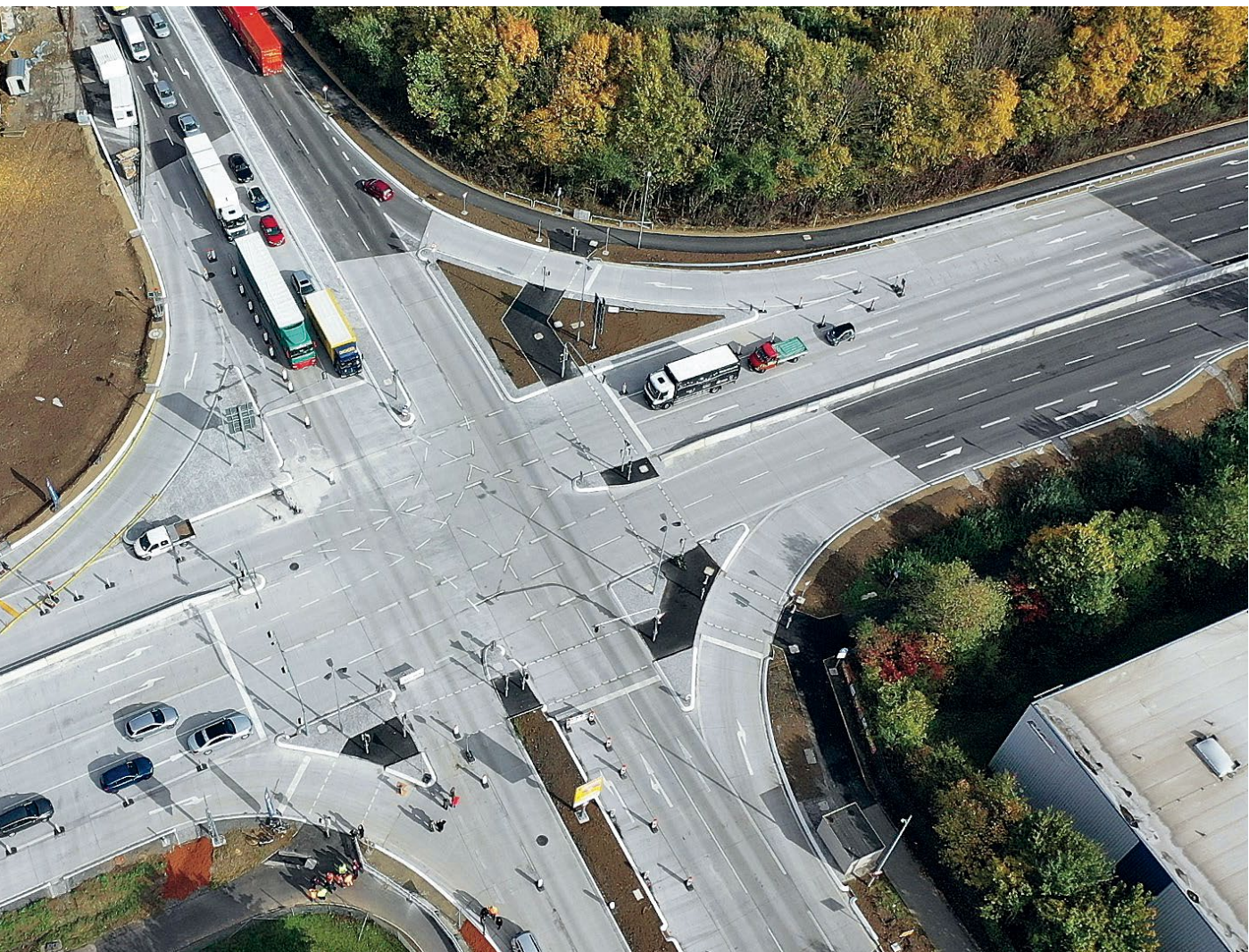
Luftaufnahme des fertiggestellten Daimler-Knotens
