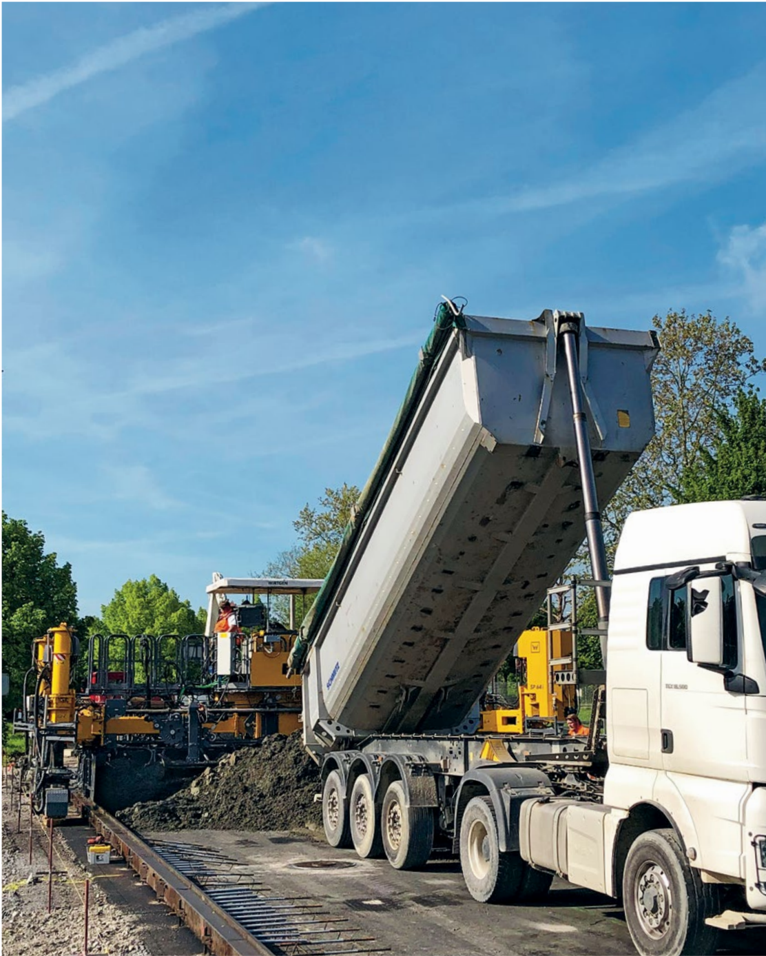
Betoneinbau mit Beton-Straßenfertiger in der Konsistenzklasse C1
