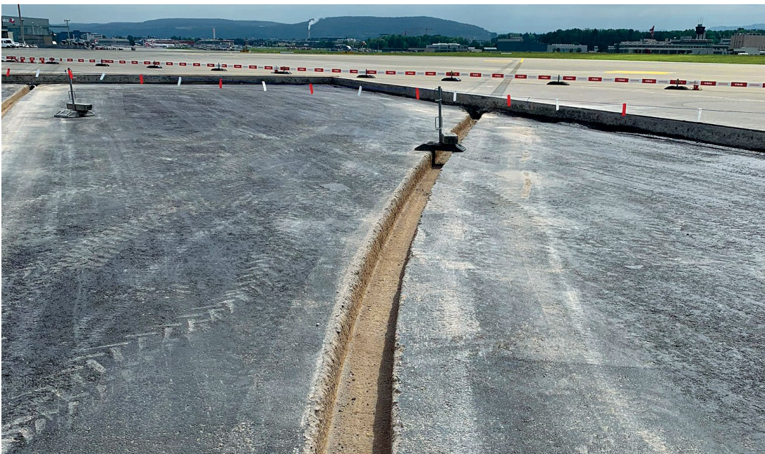
Graben für die Verlegung der Rolllinienbefeuerung
