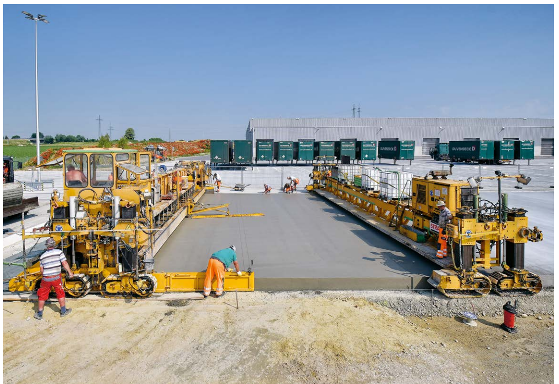
Einbau einer Betondecke
