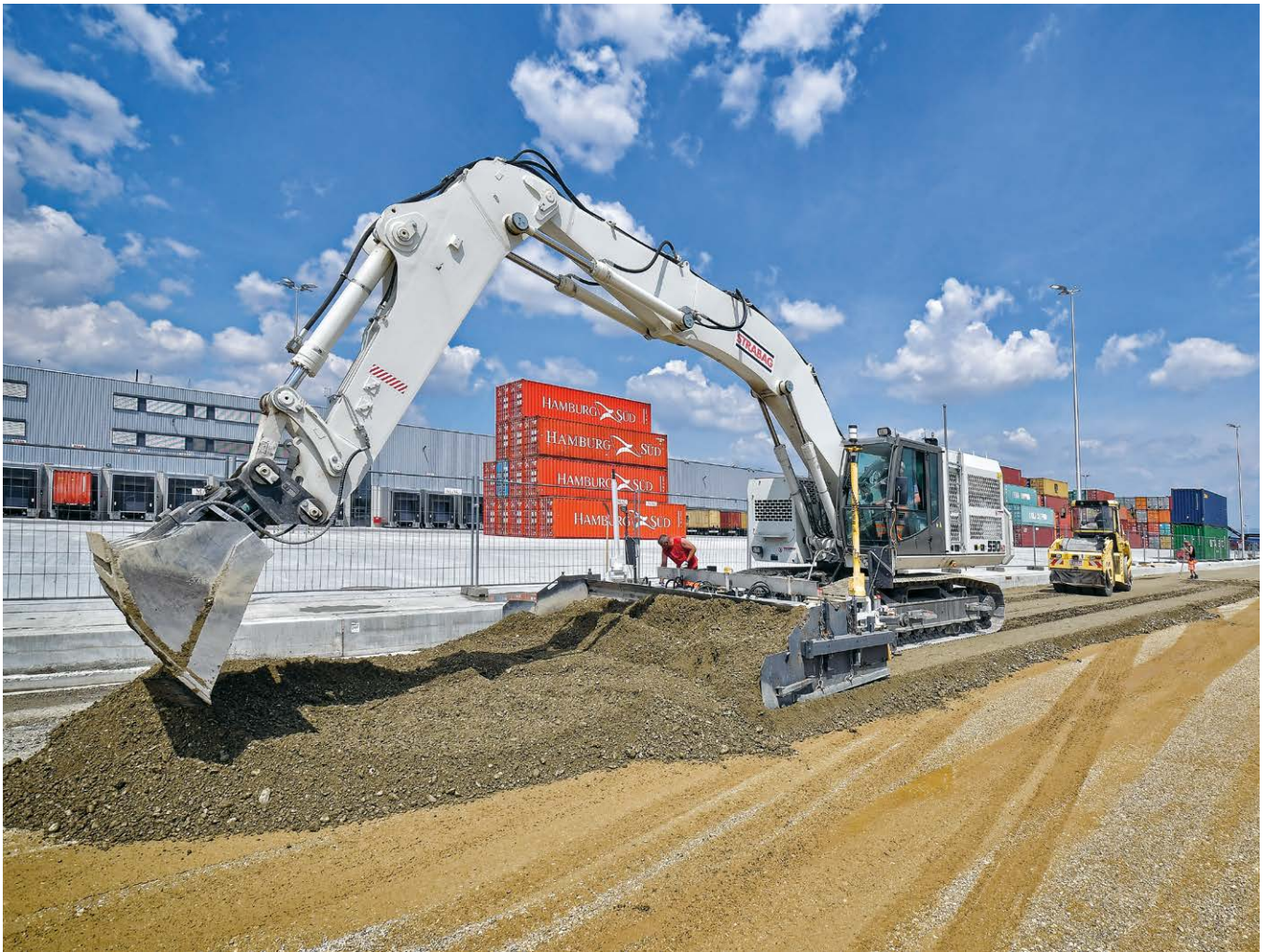
Einbau einer hydraulisch gebundenen Tragschicht
