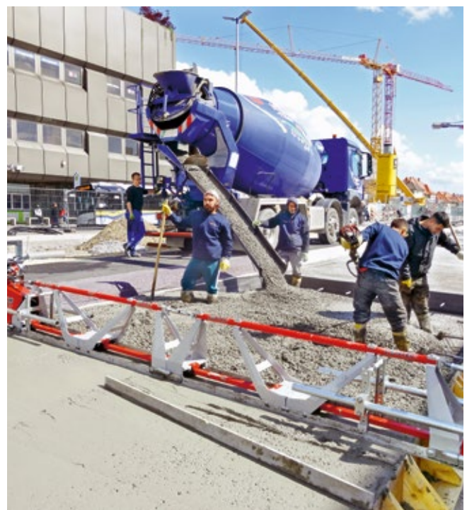
Einbringen des Betons mit Rutsche und Rüttelbohle
