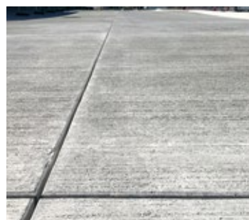
Geschnittene, noch unverfüllte Fuge
