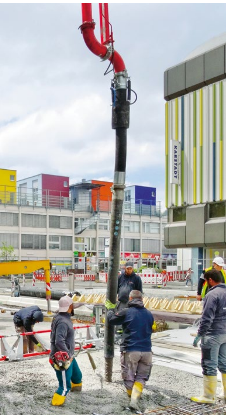
Einbringen des Betons mit Rutsche und Rüttelbohle
