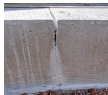
Technisch notwendiger Kontraktionsriss an der Scheinfuge in der Fahrbahnplatte
