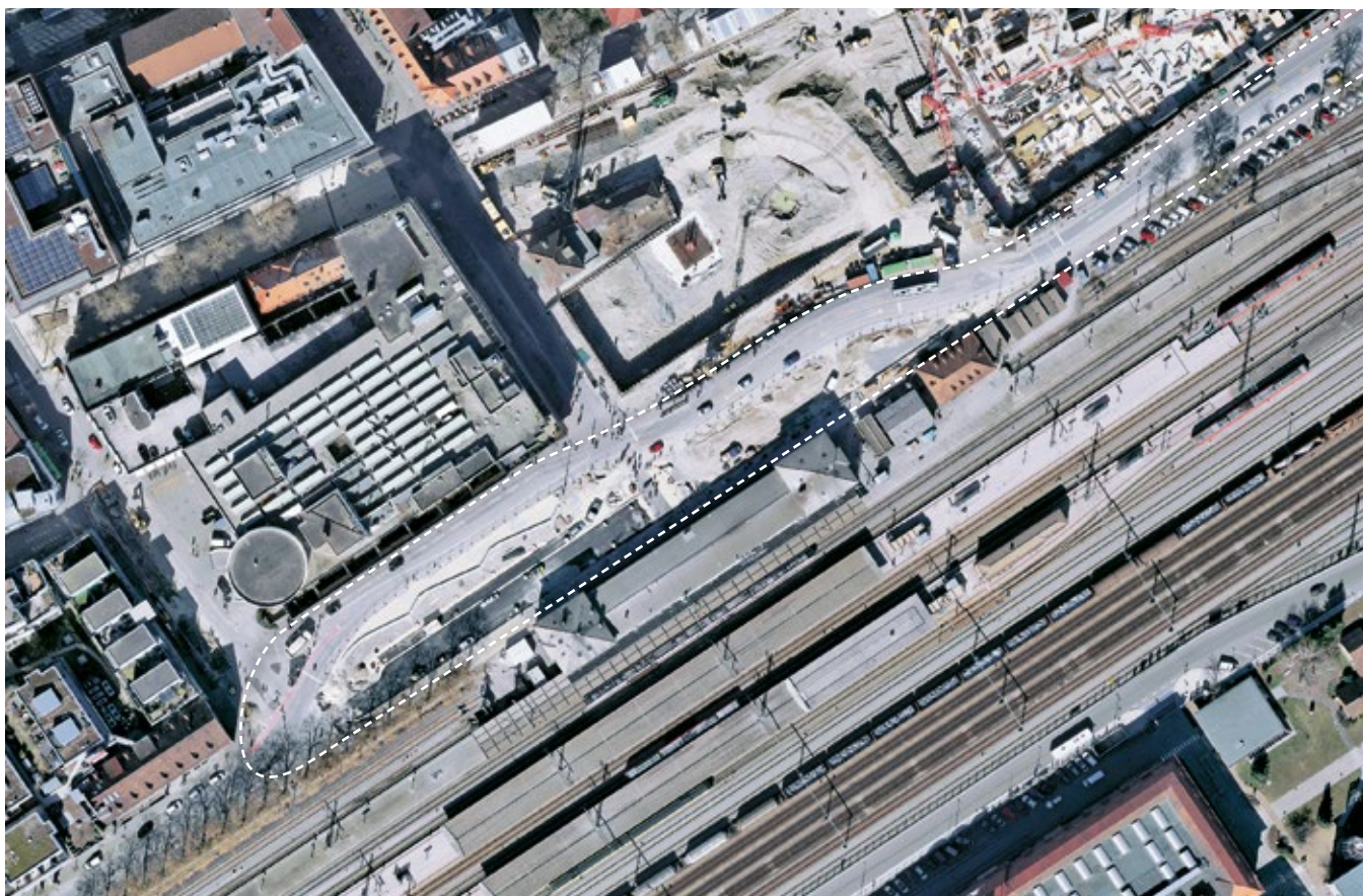
Luftbild während des Umbaus.
