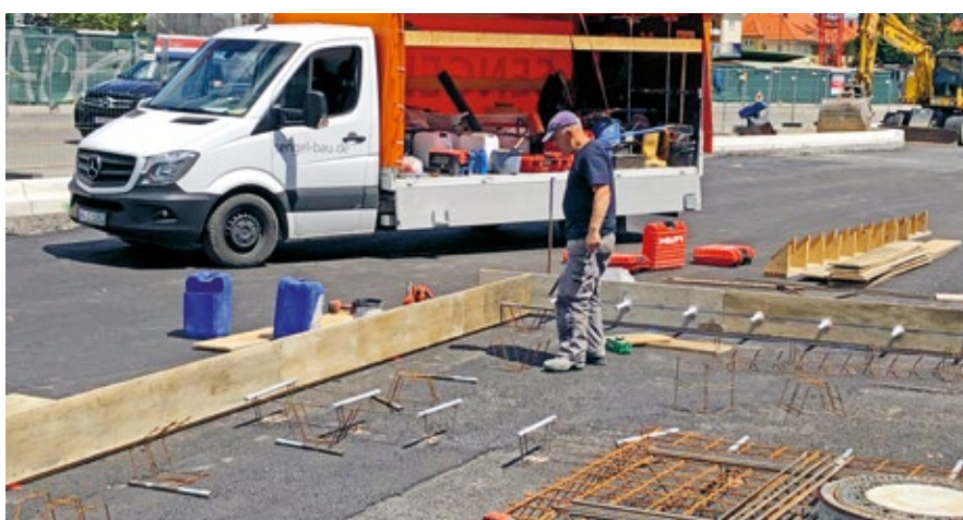
Fugen/Anker/Asphalttragschicht, Bewehrung und Raumfuge bei Einbauten
