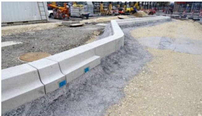
Klassisch mit «Rückenstützenbeton» («Kasseler Borde»)
