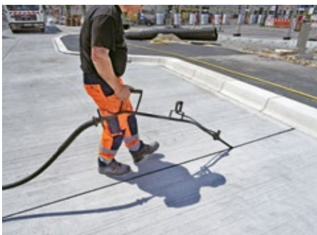
Fugenverfüllung mit Heissbitumen Typ N2
