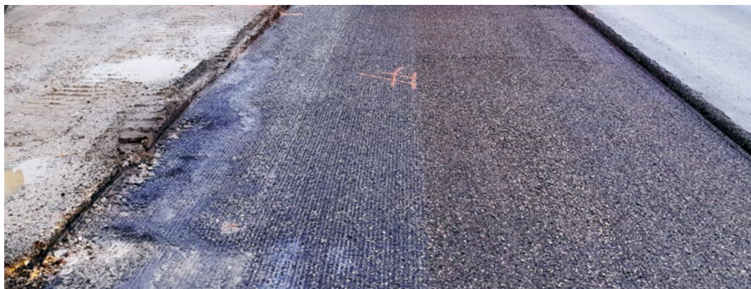
Gefräste und gereinigte Asphaltoberfläche
