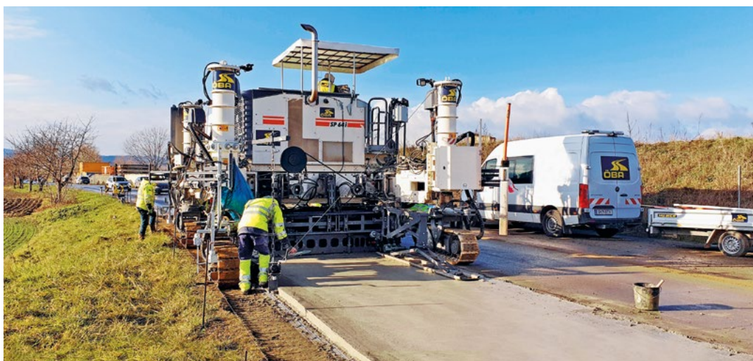
Halbseitiger White- Topping-Einbau mit Betondeckenfertiger
