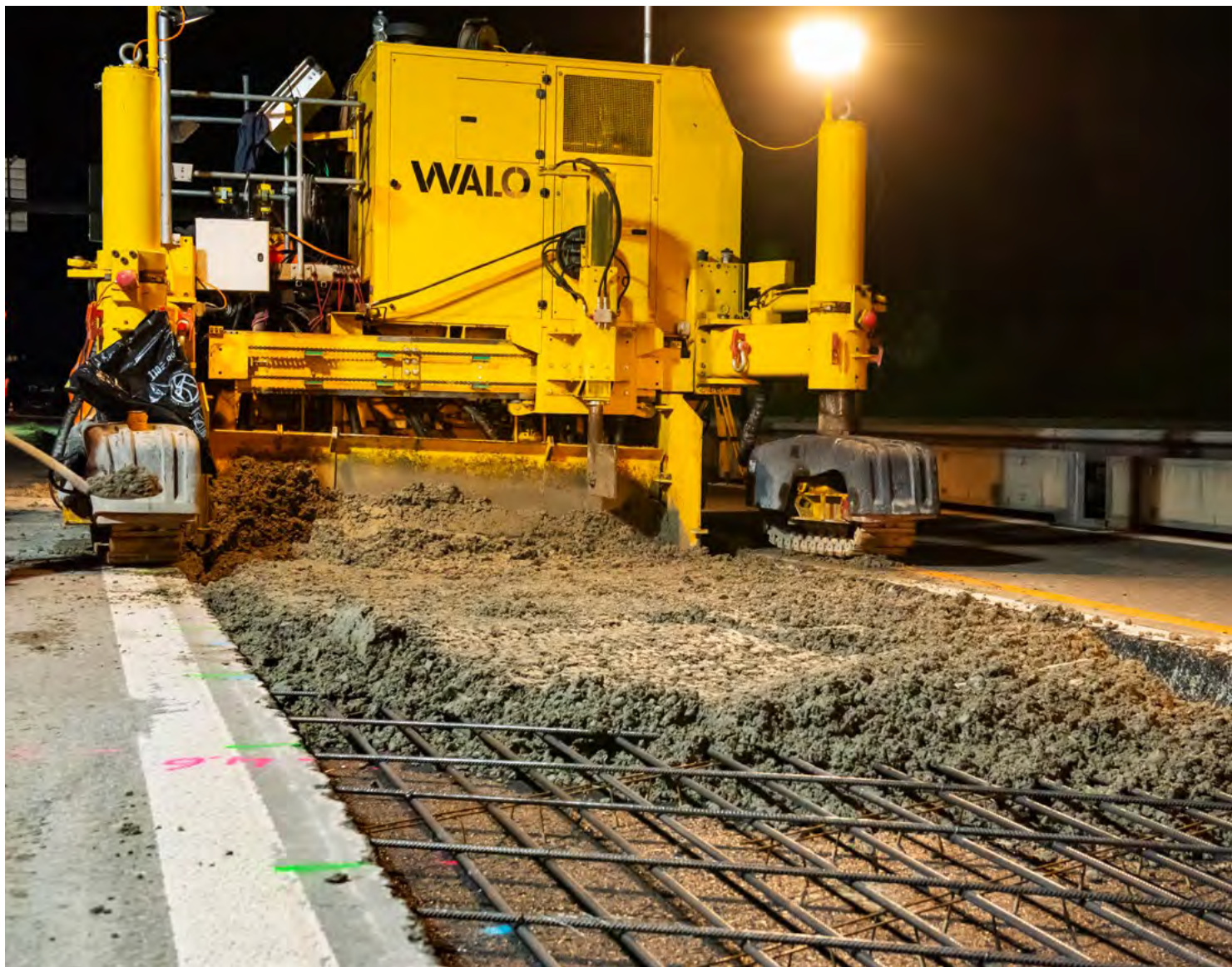
Maschineller Einbau mit Gleitschalungsfertiger
