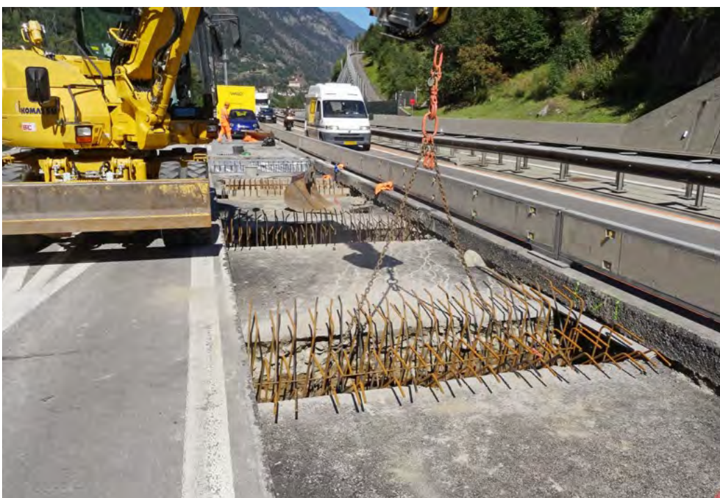
Bewehrung der Endverankerungen
