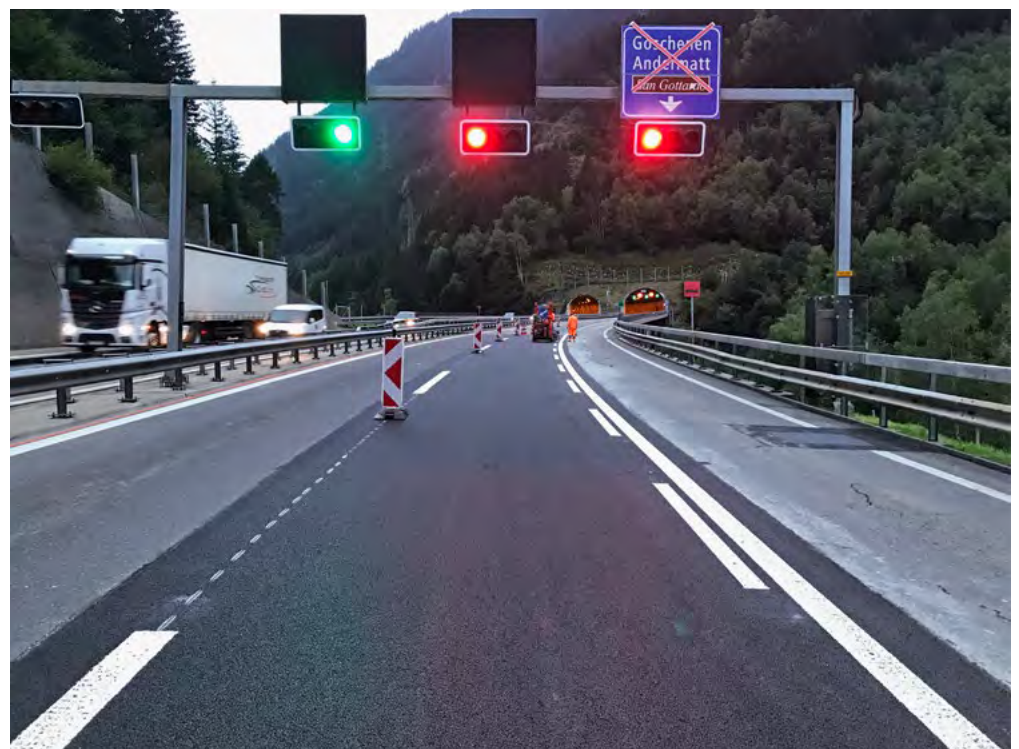
Bereit für die Verkehrsfreigabe (Blick Fahrtrichtung Süden)
