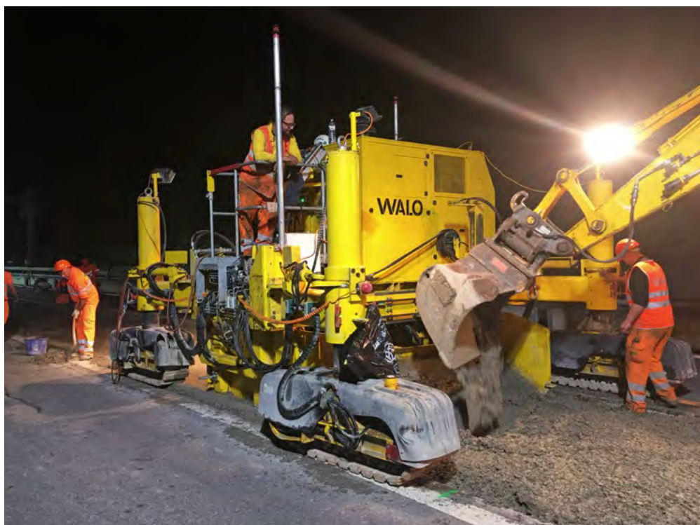
Maschineller Einbau mit Gleitschalungsfertiger
