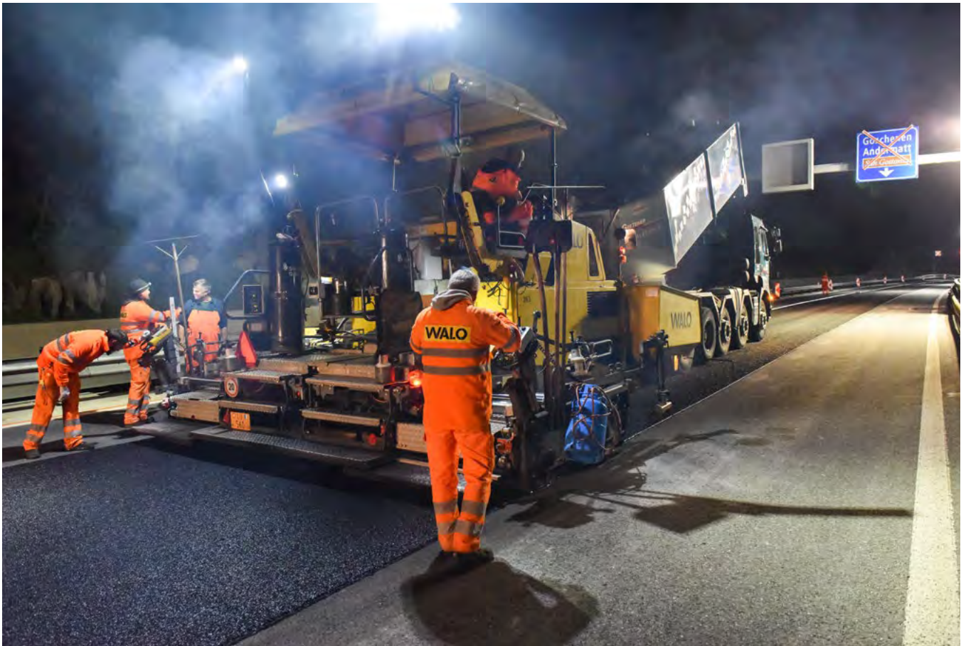
Deckbelagseinbau SDA 8-12
