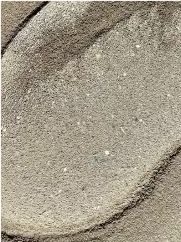
Betonoberfläche verzögert und Zementhaut entfernt (ausgebürstet)
