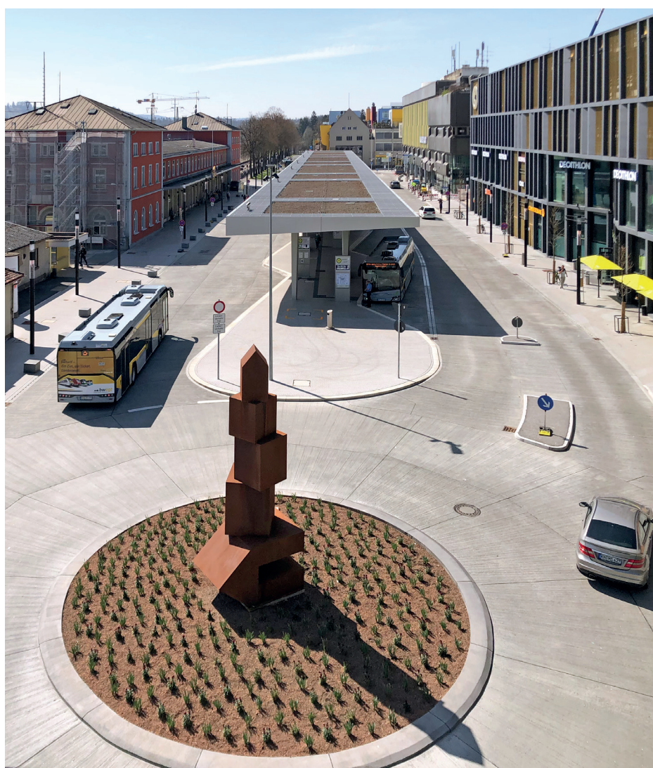
Ein Beispiel für den nachhaltigen Einsatz von Beton im modernen Straßenbau: der stark frequentierte Omnibusbahnhof in Singen. Der Einsatz von Beton sichert hier eine Lebensdauer von mindestens 30 Jahren.
