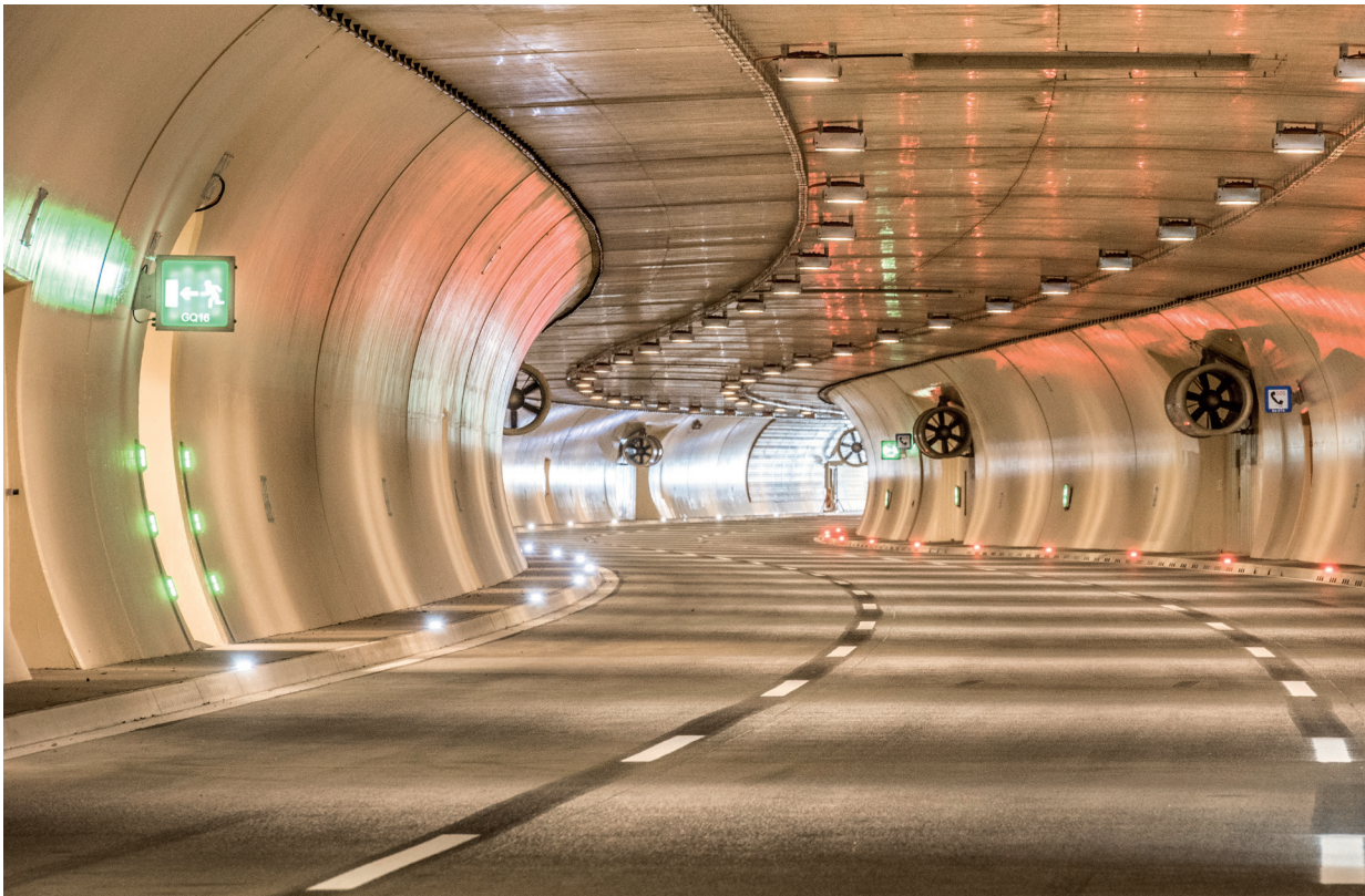
Betonfahrbahnen im Tunnel haben zwei wesentliche Vorteile: Durch die guten lichttechnischen Eigenschaften des Betons lässt sich das subjektive Sicherheitsgefühl steigern und der Energieaufwand für die Beleuchtung senken. (Im Bild: Tunnel Götschka, Oberösterreich)
