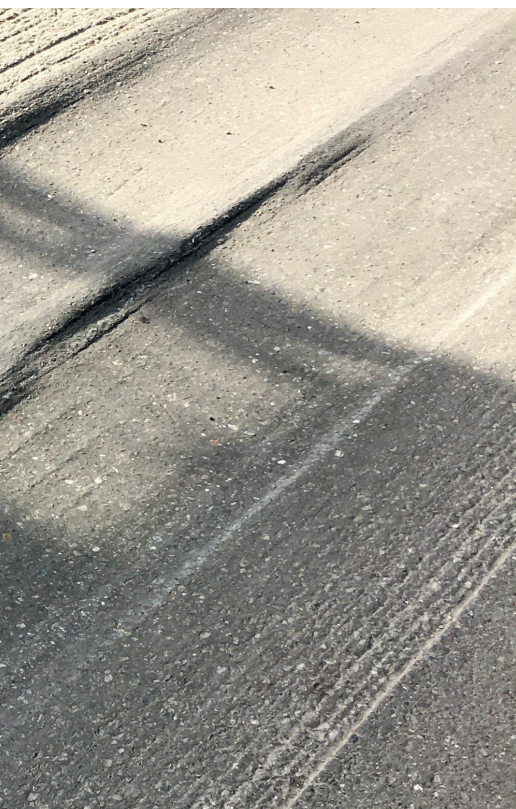
Exemple d'orniérage sous l'effet du trafic de poids lourds et des températures élevées.
