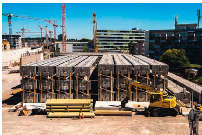
Trägerlager; Bild: Bundesamt für Strassen ASTRA
