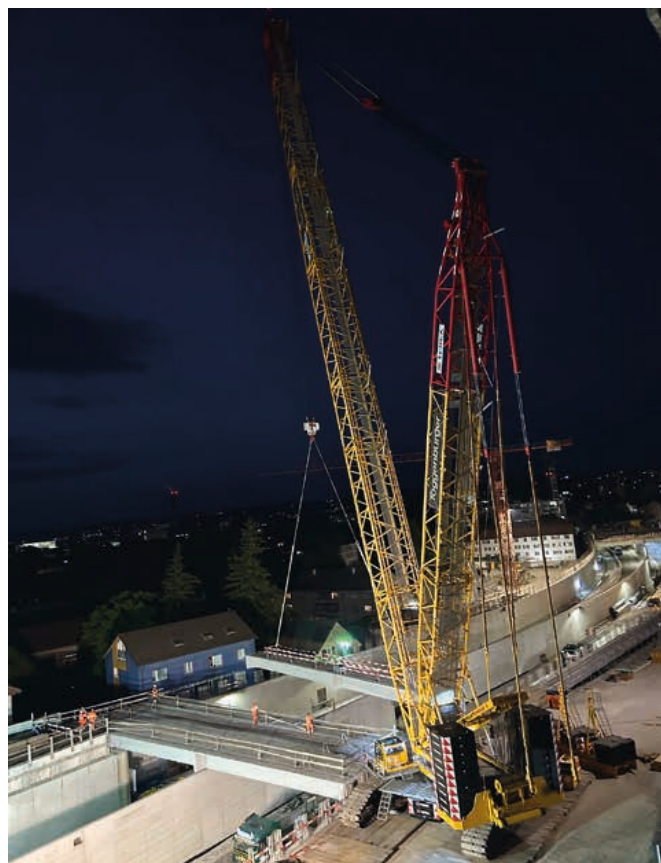
Präziser Nachteinsatz: Ein Betonträger mit 30 Metern Spannweite wird millimetergenau positioniert. Bild: INGE K12plus
