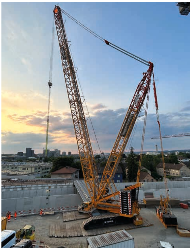
Der 650-Tonnen-Raupenkran im Einsatz bei der Einhausung Schwamendingen. Bild: INGE K12plus
