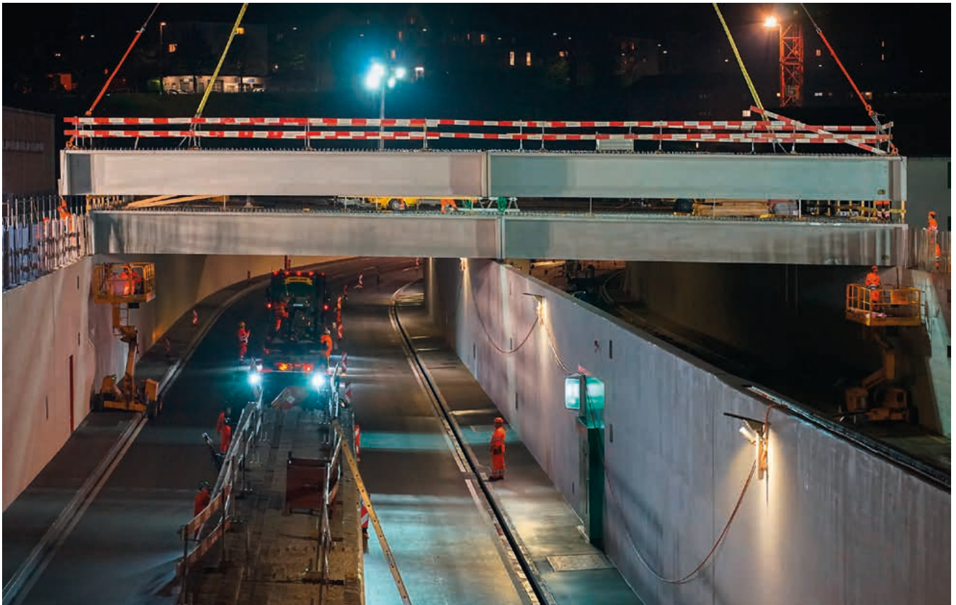
Träger um Träger zum Deckel. Der Einbau der dafür massgefertigten Deckenträger beruht auf planerischen, logistischen und bauhandwerklichen Meisterleistungen. Bild: leistungsfotografie.ch
