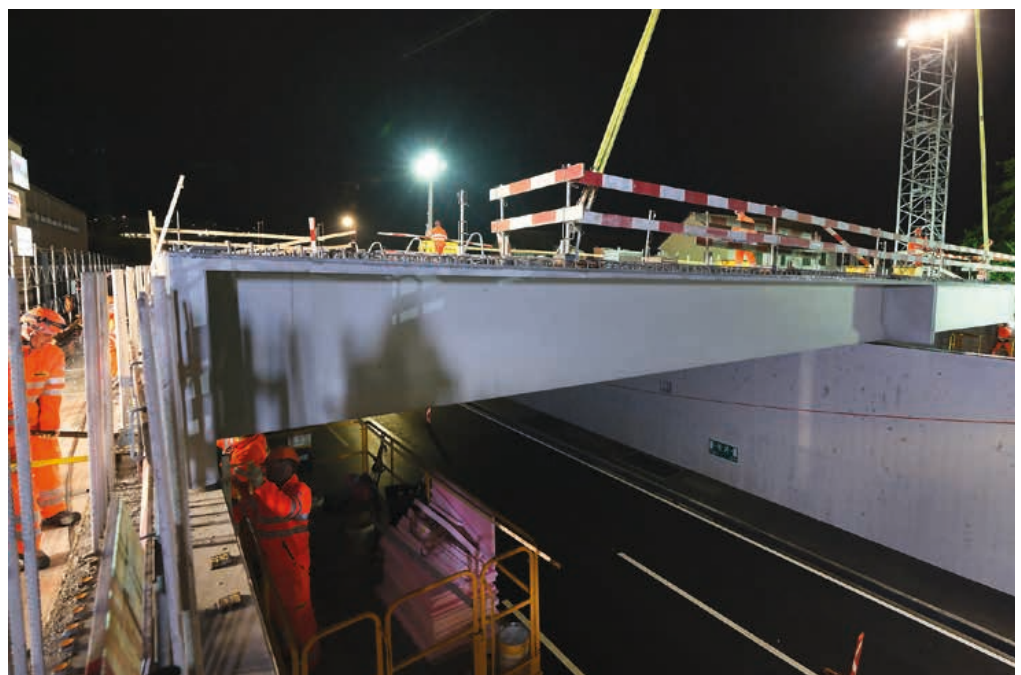
Präzisionsarbeit bei Nacht: Der 70 Tonnen schwere Beton- träger wird millimetergenau plat- ziert – von der Anhebung bis zum endgültigen Aufliegen auf der tragenden Struktur ist dies ein Zusammenspiel modernster Technik und präziser Handarbeit. Bilder: leistungsfotografie.ch
