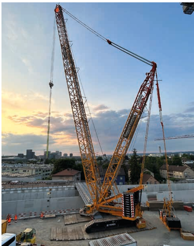
La grue sur chenilles de 650 tonnes à l'œuvre au-dessus de la tranchée couverte de Schwamendingen. Photo : INGE K12plus
