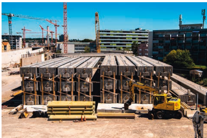
Entreposage des travées ; photo : Office fédéral des routes OFROU
