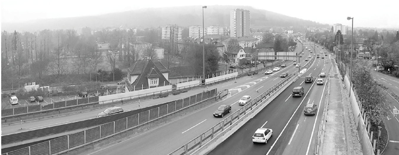
La situation à Schwamendingen avant la construction de la tranchée couverte ; photo : OFROU, division Infrastructure routière, filiale de Winterthour
