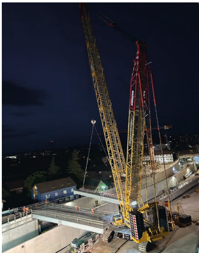
Opération nocturne de haute précision : les travées en béton de 30 mètres de portée sont positionnées au millimètre près. Photo : INGE K12plus
