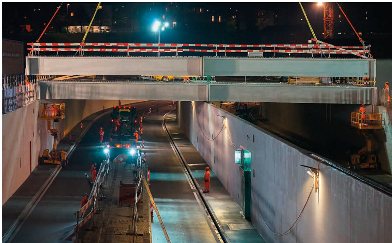
Travée après travée, la tranchée se couvre. La mise en place des travées fabriquées sur mesure s'appuie sur des prouesses en termes de planification, de logistique et de construction. Photo : leistungsfotografie.ch
