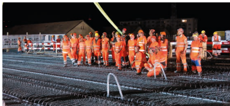
Le soir du 15 juin 2023, les derniers modules de couverture ont été installés avec succès. Photo : Werner Aebi
