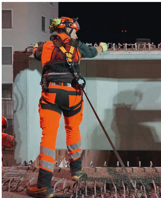
Cette photo met bien en évidence les fers de raccord de la couche de surbêton coulée sur place au-dessus des travées. Au stade final, le système statique implique un encastrement partiel dans les parois latérales. Photo : leistungsfotografie.ch
