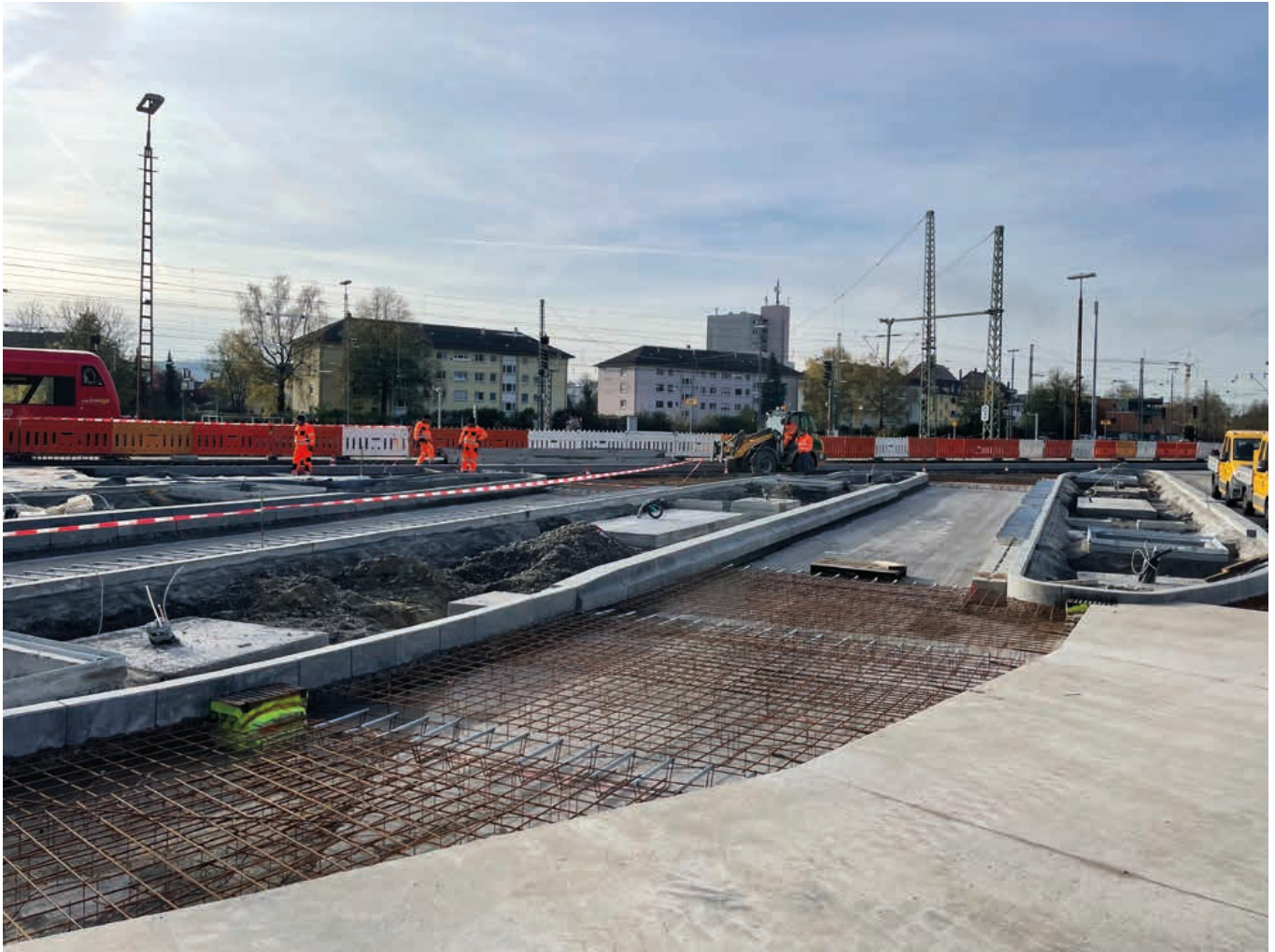
Einbau der Borde: Die Bewehrung war aufgrund abweichender geometrischer Plattenverhältnisse nötig.
