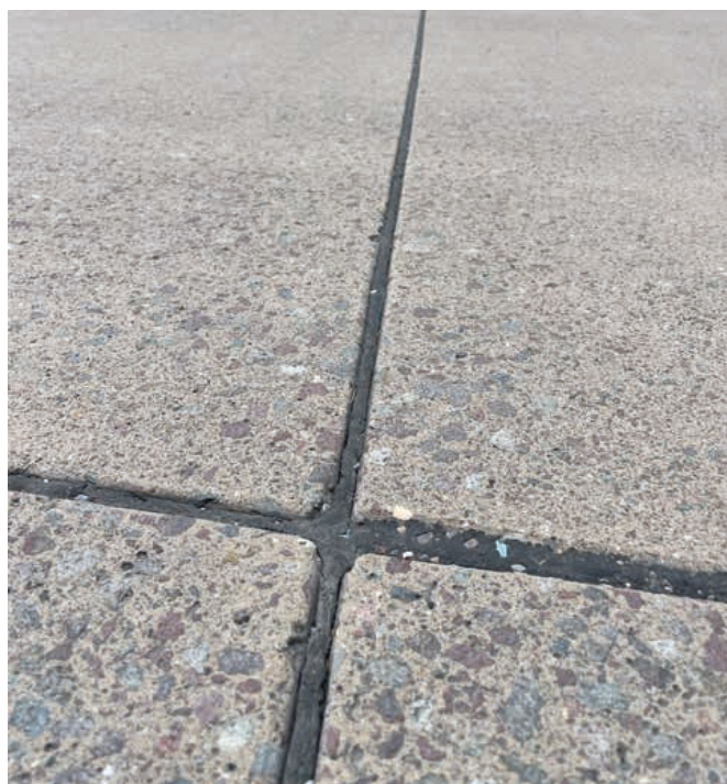
Flächengestockte Oberfläche mit heiß verfülltem Scheinfugenkreuz und sichtbarer WS-Gesteinskörnung
