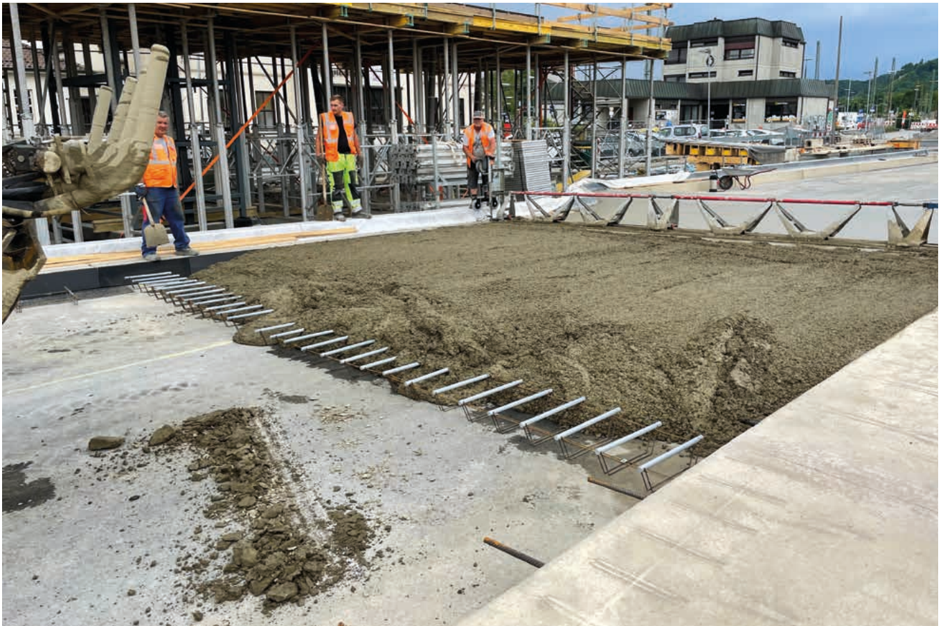
Einbringen des Betons mit Rutsche und Rüttelbohle
