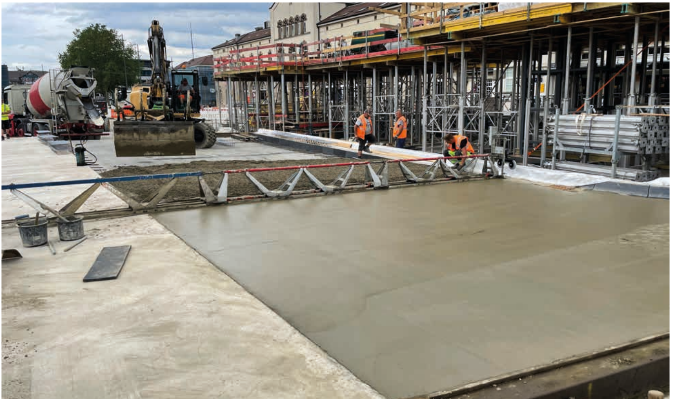
Durch die Rüttelbohle abgezogene Betonoberfläche
