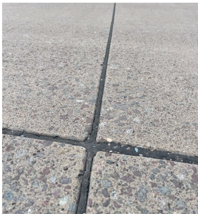
Surface bouchardée avec croisée de joints de retrait comblés à chaud et granulométrie WS visible
