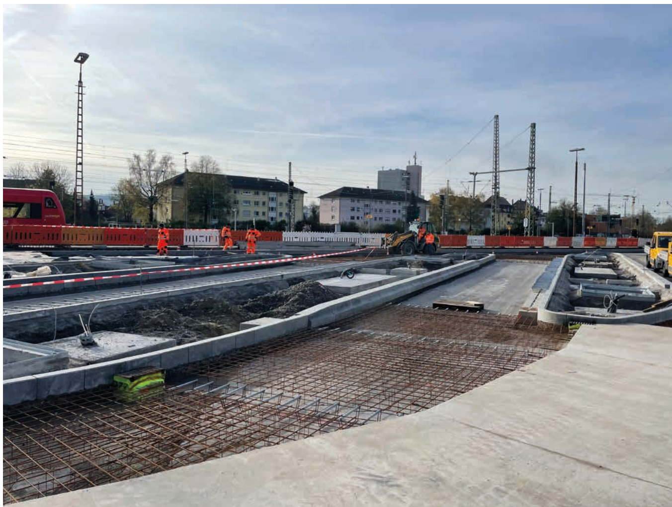
Pose des bordures : en raison des écarts de géométrie des dalles, une armature était nécessaire.
