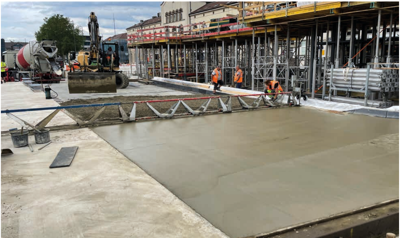
Surface bétonnée égalisée à l'aide de la poutre vibrante
