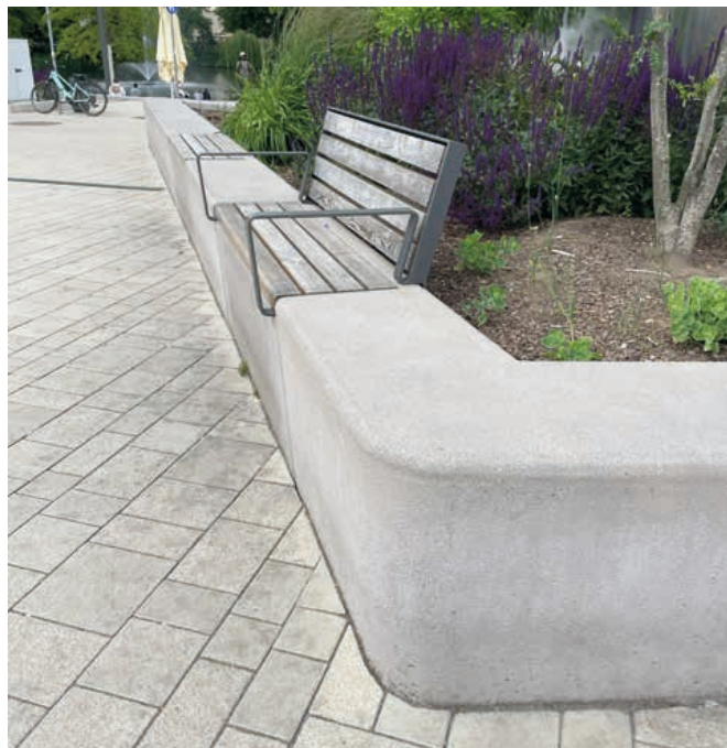
Les bordures des parterres végétalisés, auxquelles sont intégrés des sièges, sont également en béton.
