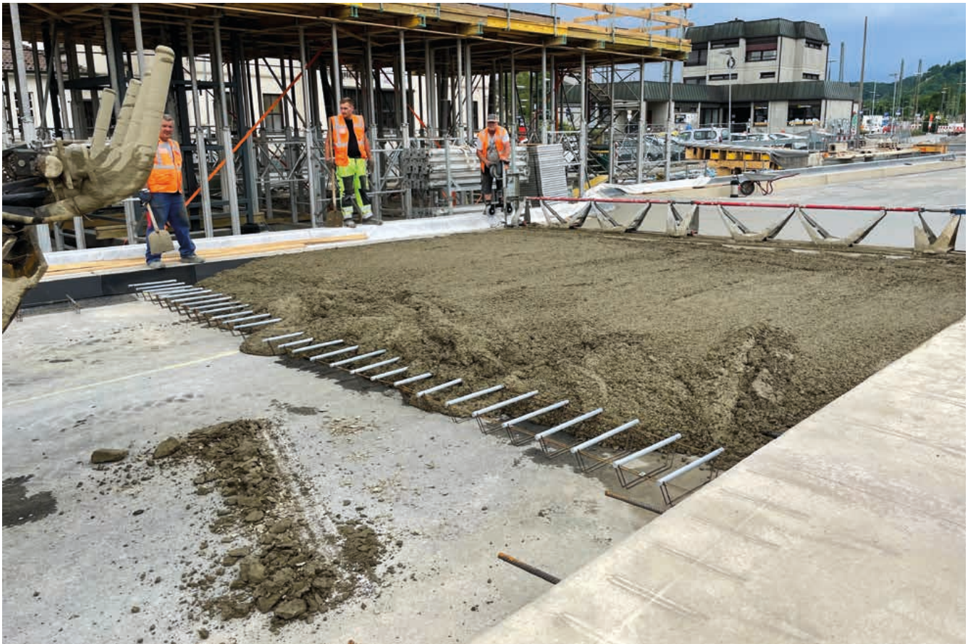
Mise en œuvre du béton avec toboggan et poutre vibrante
