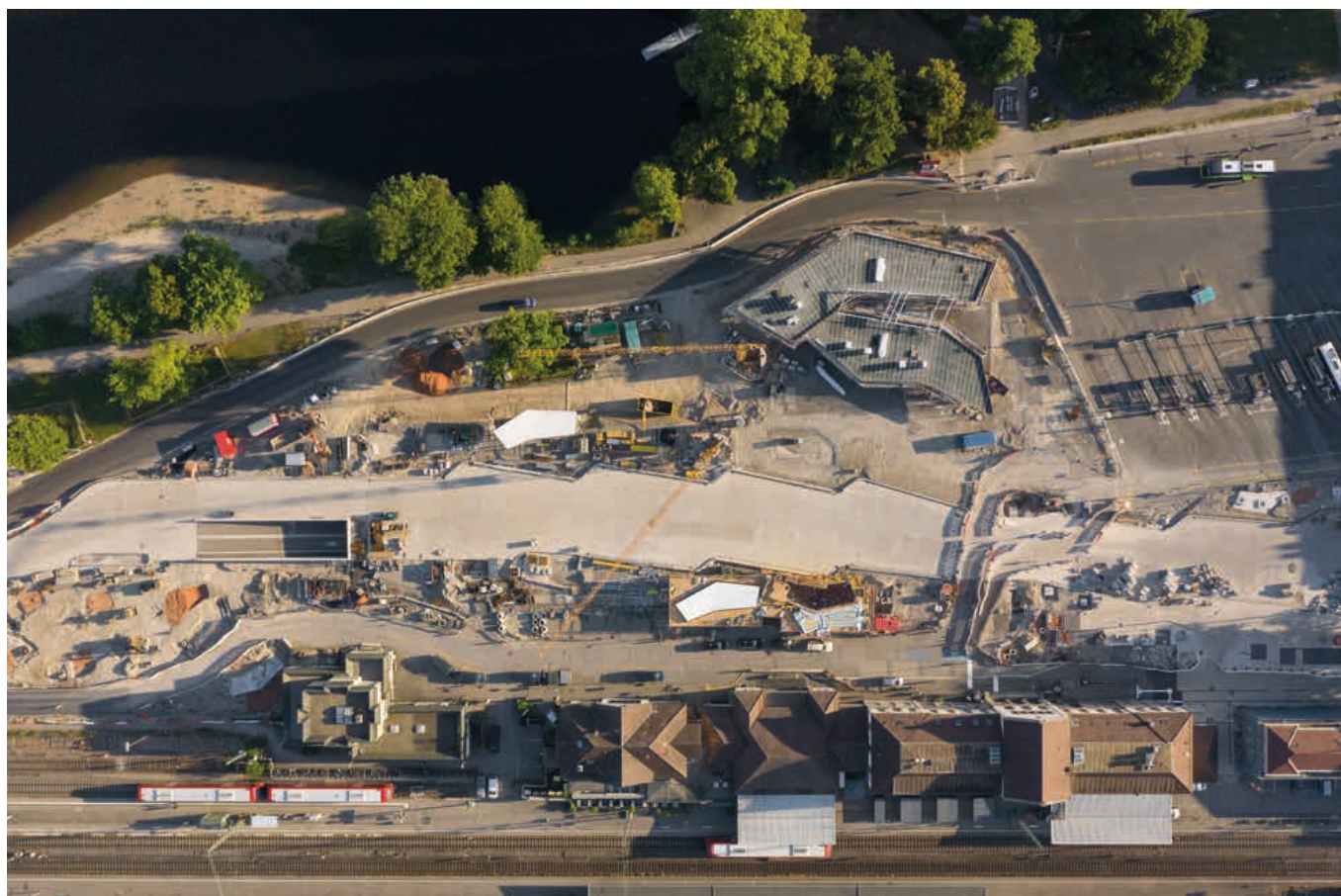
Le nouvel agencement des quais devrait fluidifier la circulation des bus.
