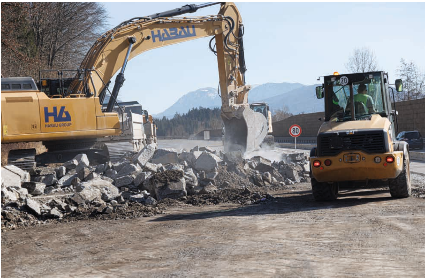
Der Abtrag wird auf Lkw verladen und abtransportiert.
