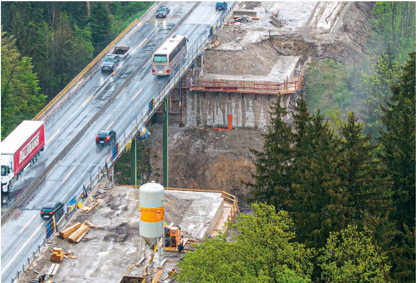
Insgesamt 28 Brückenbauwerke umfasste das Baulos. Hier die Ölgrabenbrücke
