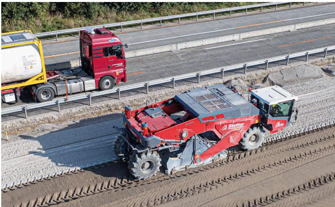
Stabilisation au ciment : le béton retraité a été utilisé dans le béton inférieur ou la couche de base stabilisée au ciment.
