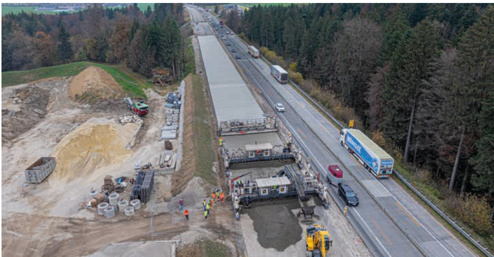
Réfection générale sans interruption de trafic
