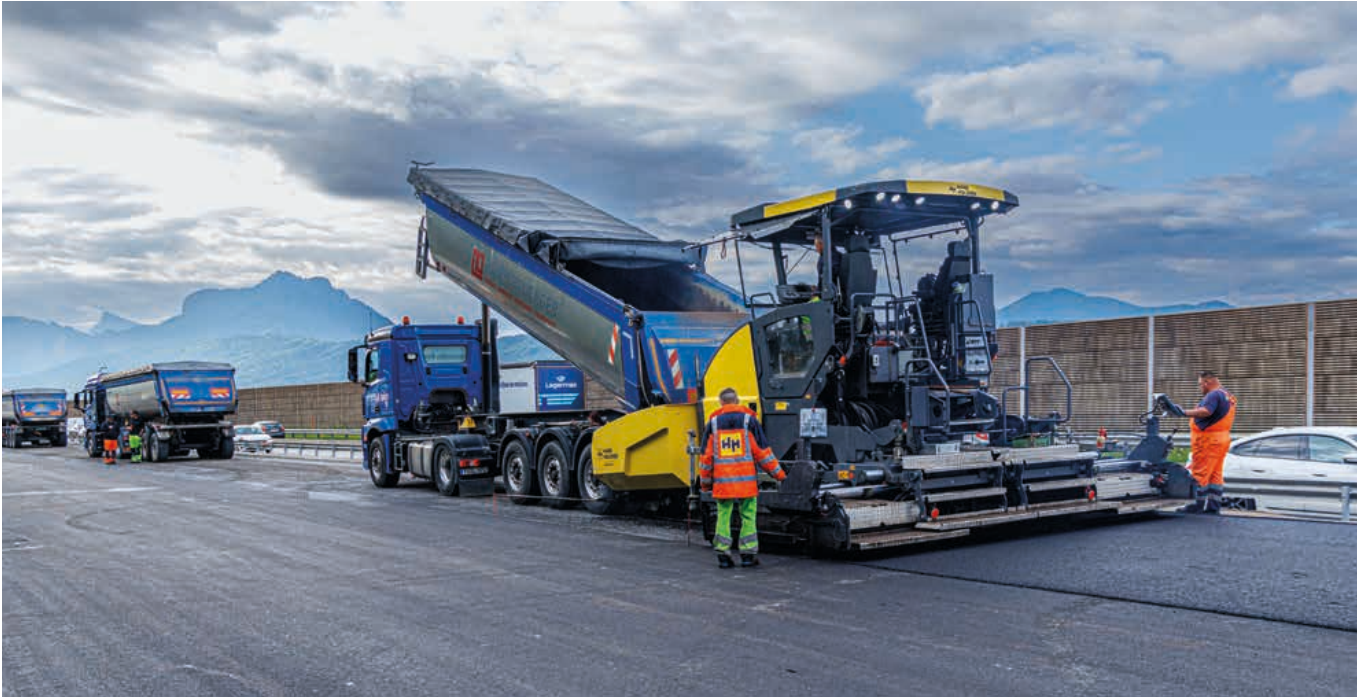
Mise en œuvre d'une couche de base bitumeuse de 5 cm
