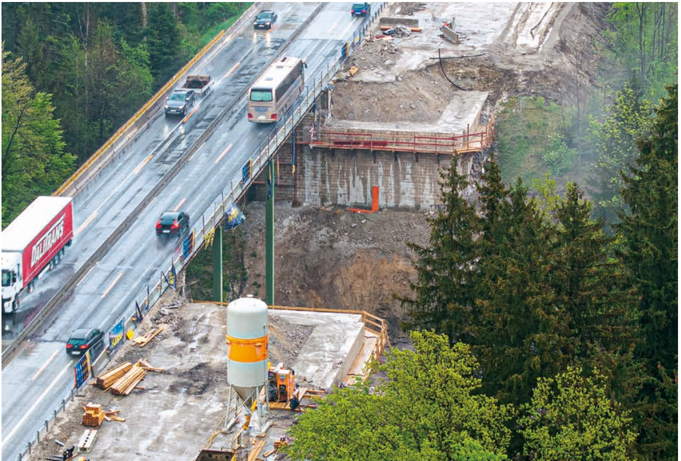
Le lot comprenait au total 28 structures de pont. Ici, le pont d'Ölgraben.
