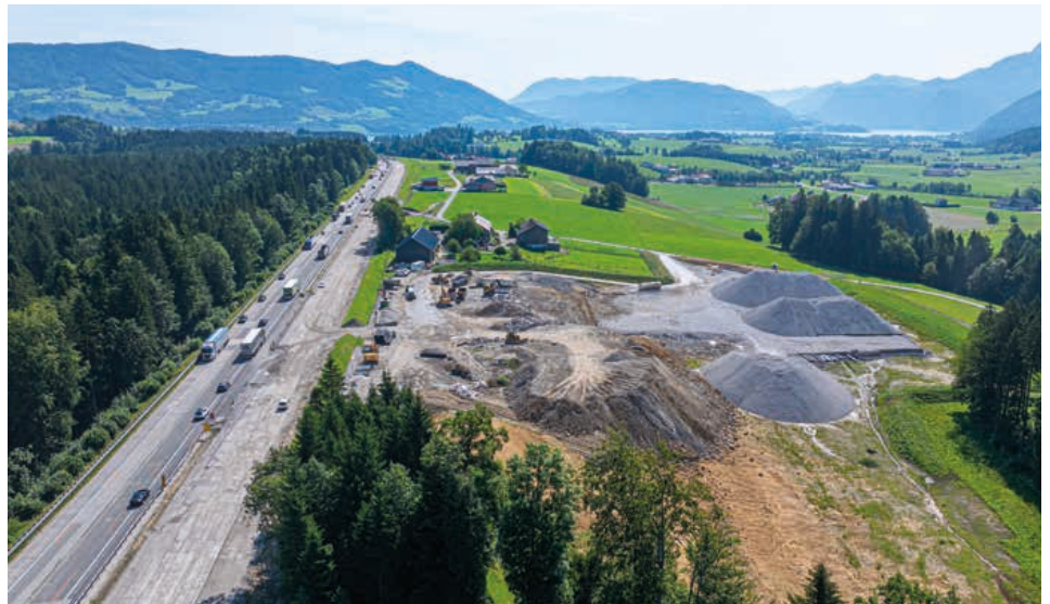
Retraitement du béton directement sur le chantier : un gain de 70 % de granulats primaires
