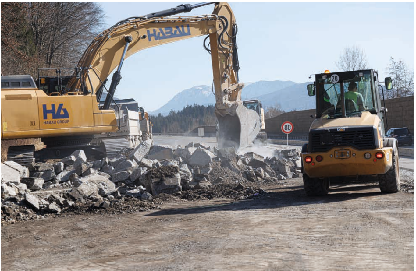
Les gravats sont chargés sur des camions et évacués.
