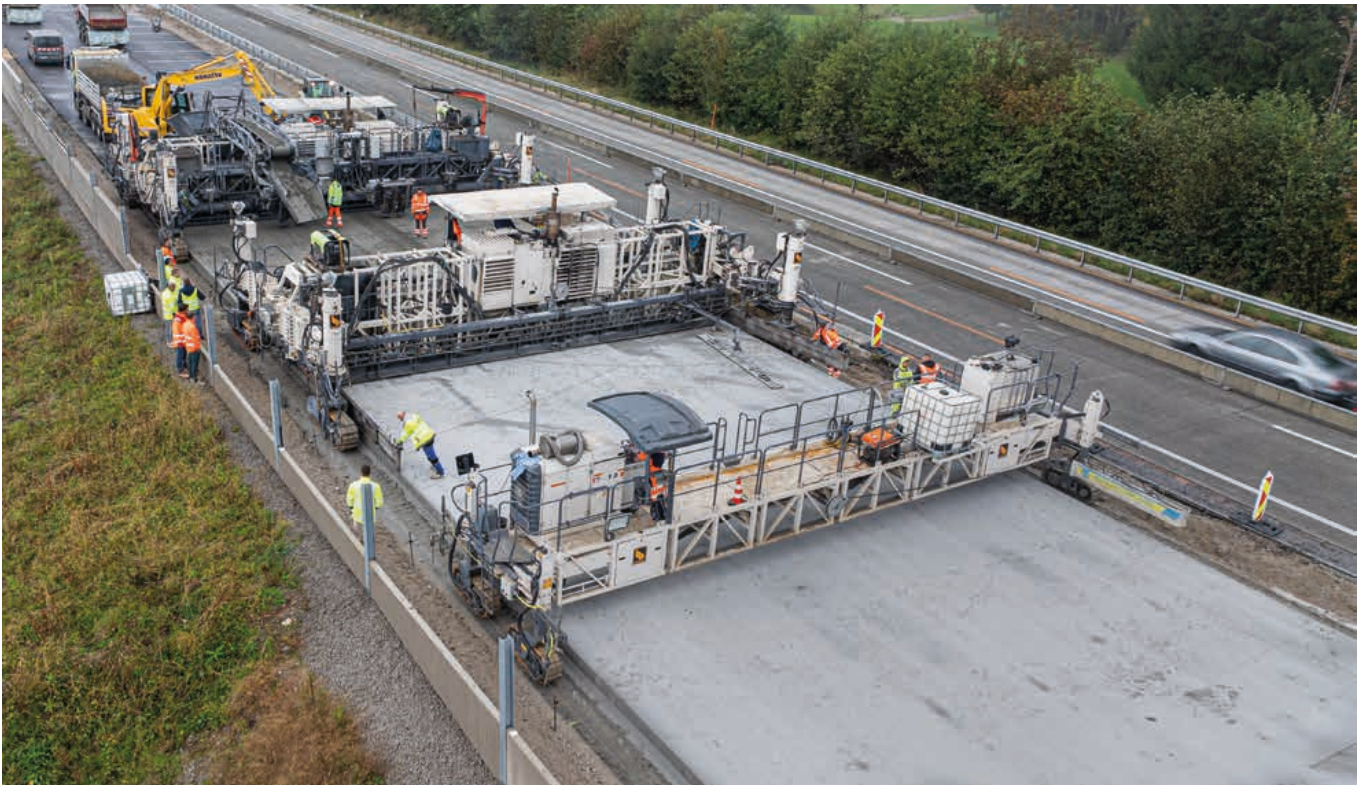
Finisseur à coffrage glissant SP 1500 de Wirtgen : le finisseur pour béton inférieur met en place la couche du dessous. La couche du dessus est posée en « humide sur humide » au moyen du finisseur pour béton supérieur.
