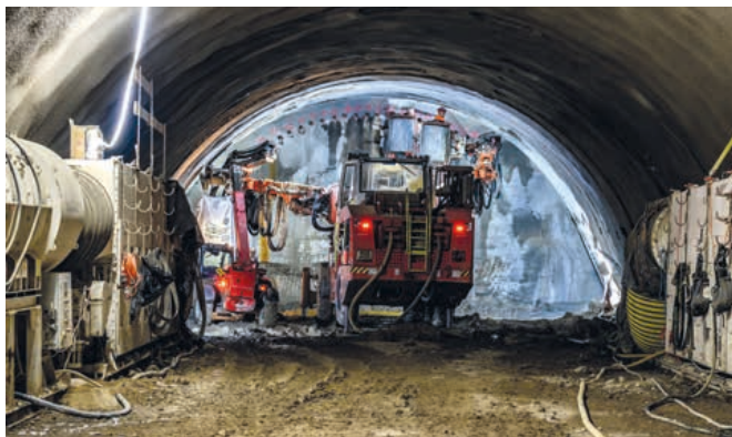
Erstellung der Bohrungen für den Rohrschirm
