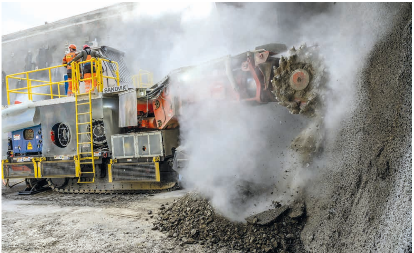
Die für den Ausbruch des Tunnels Städtlerwald eingesetzte, elektrische Teilschnittmaschine wiegt 135 Tonnen und lässt sich von einem einzigen Maschinenführer bedienen.
