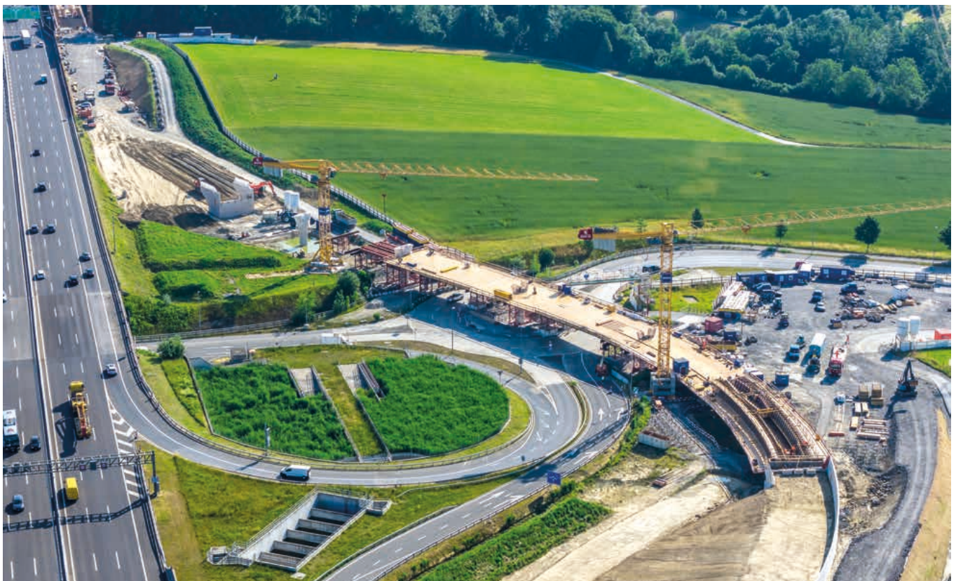
Die Brücke Gibelfeld ist S-förmig und überquert in rund sechs Metern Höhe einen Kreislauf. Ein Pfeiler befindet sich in der Mitte des Kreislaufs.
