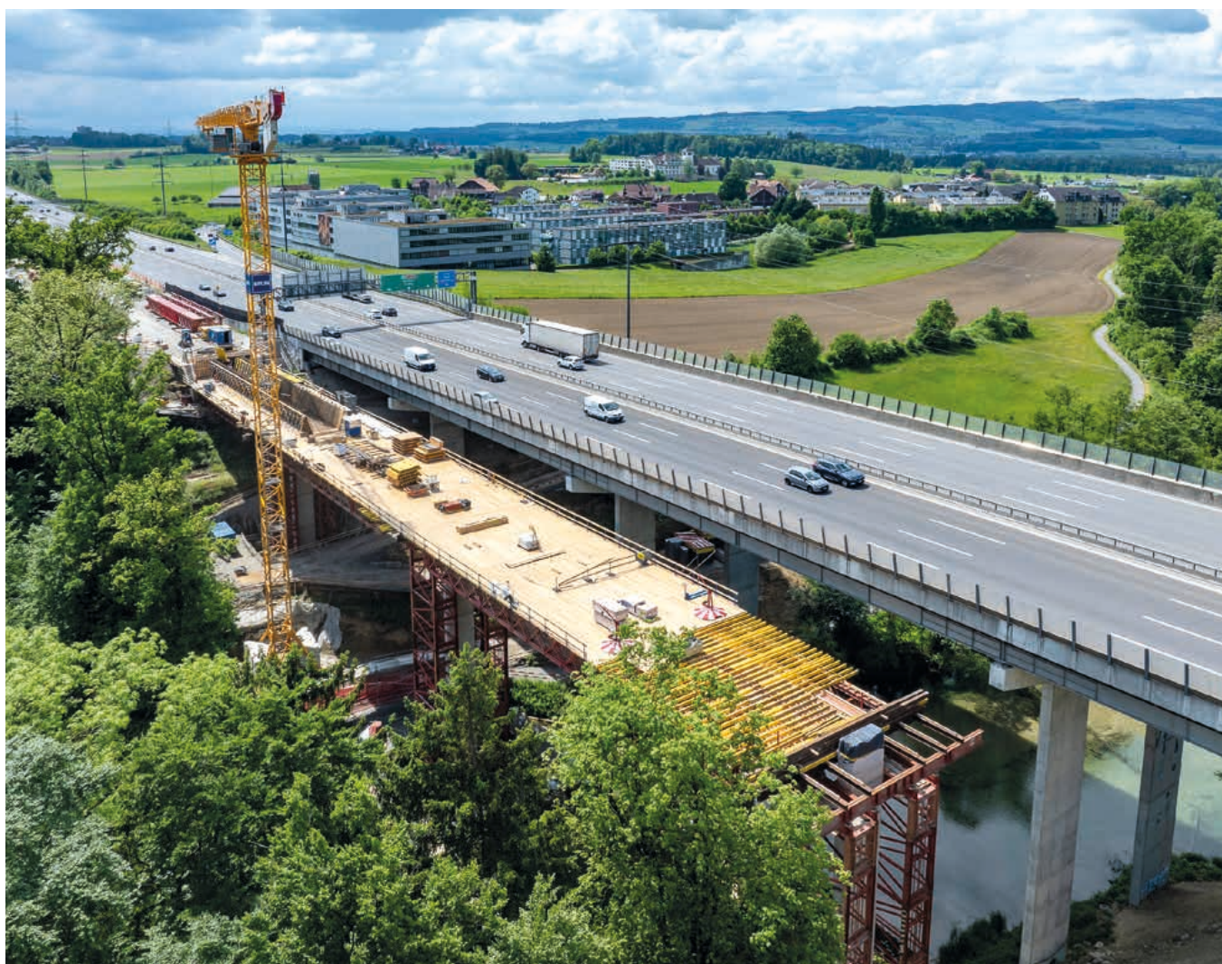
Préparation des armatures et des coffrages pour le caisson en V
