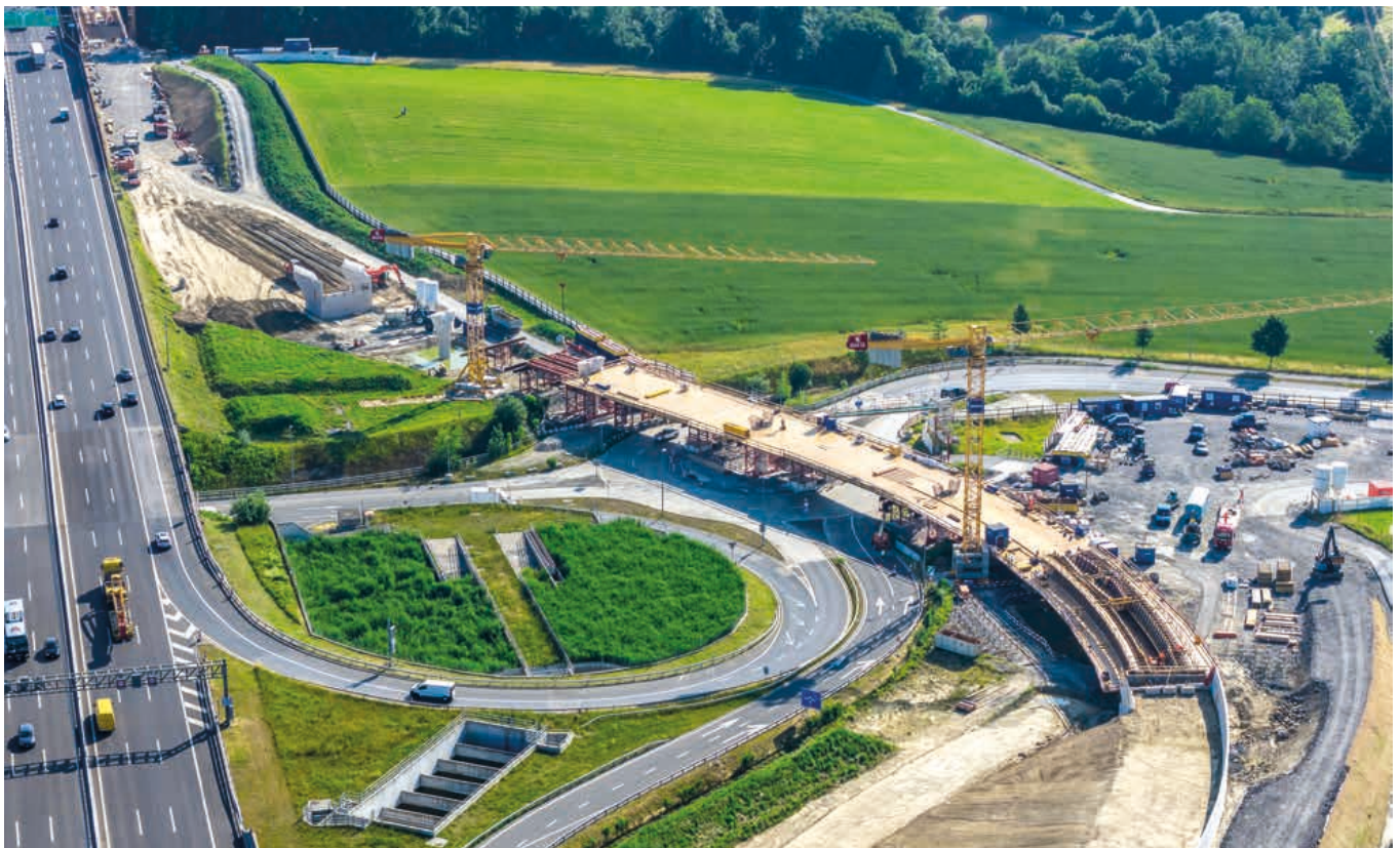
Le pont de Gibelfeld a une forme en S et enjambe un giratoire à environ 6 mètres de hauteur. Une pile se dresse au centre du giratoire.
