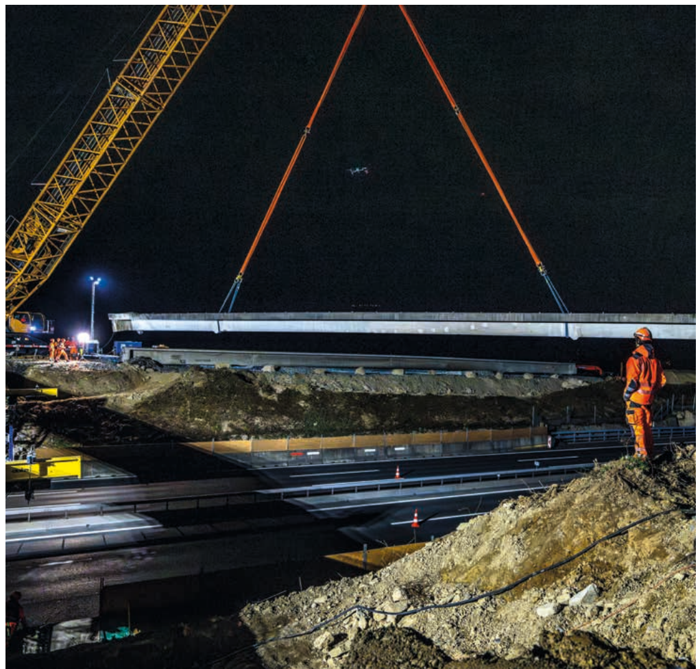
Manuel Sigrist surveille le démantèlement nocturne du pont autoroutier d'Eret.
