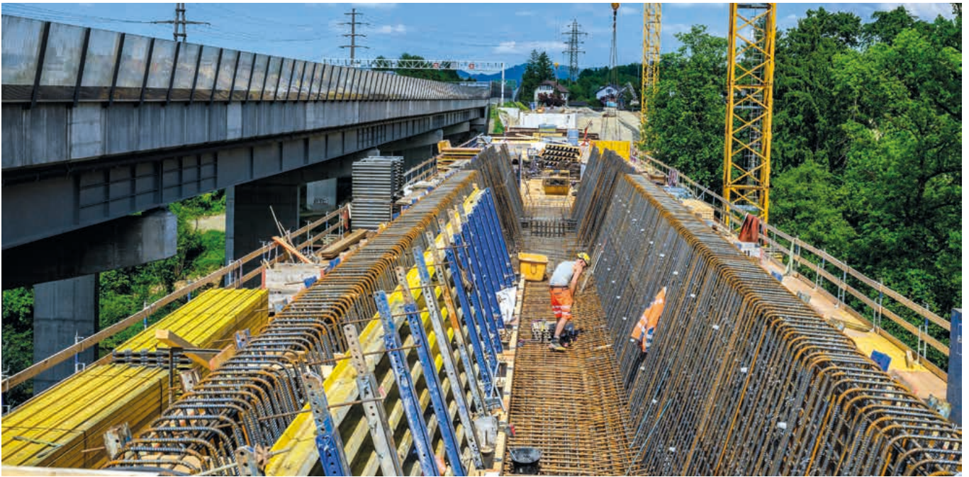
Préparation des armatures et des coffrages pour le caisson en V
