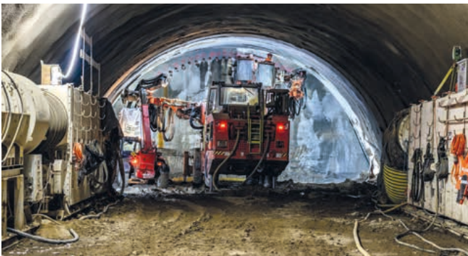
Exécution des forations pour la voûte parapluie
