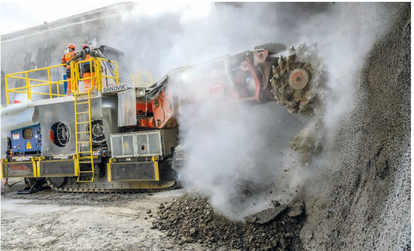
La machine à attaque ponctuelle électrique utilisée pour le percement du tunnel de Städtlerwald pèse 135 tonnes et est pilotée par un seul opérateur.
